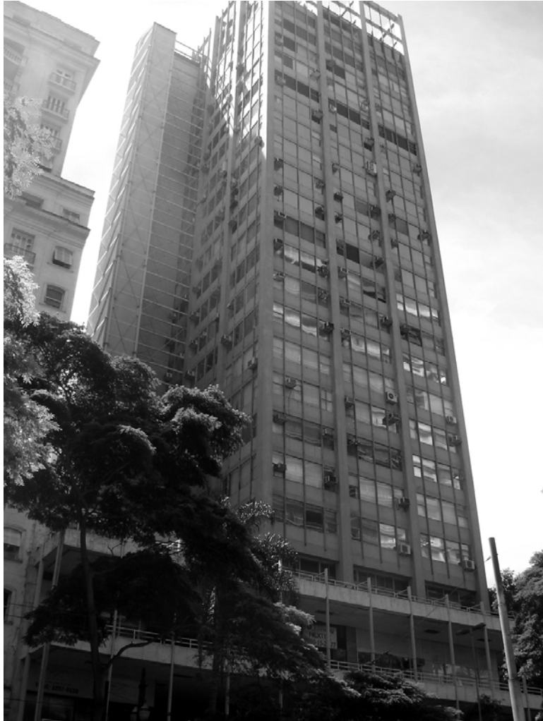
Edifício Metrôpole São Paulo Vista desde a av. São Luiz. Fonte: imagem do autor, 2008.
