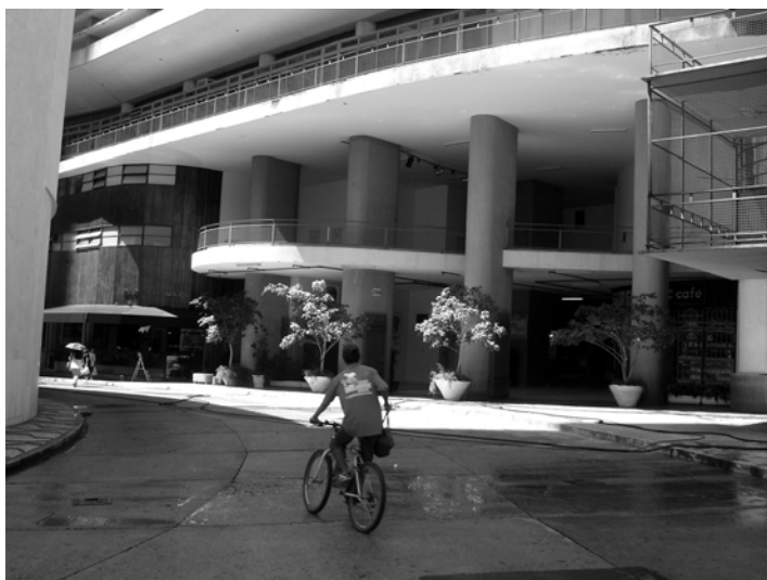
Edifício Copan São Paulo Entrada principal galeria térreo Fonte: imagem do autor, 2008.
