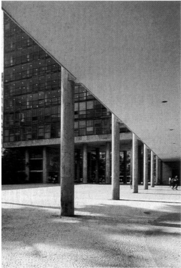
Ministério da Educação e Saúde Pilotis em dois níveis, primeiro e segundo plano. Passagem da escala do pedestre à escala urbana Rio de Janeiro Fonte: BOTEY, 1997: 97
