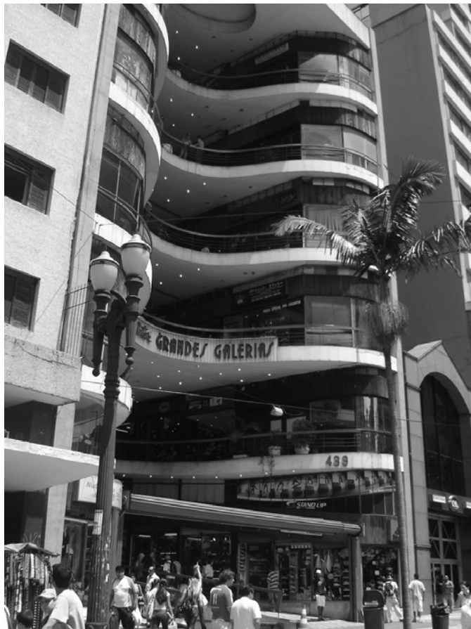
Grandes Galerias São Paulo Vista desde a avenida São João, defronte ao Largo do Paissandú. Fonte: imagem do autor, 2008.
