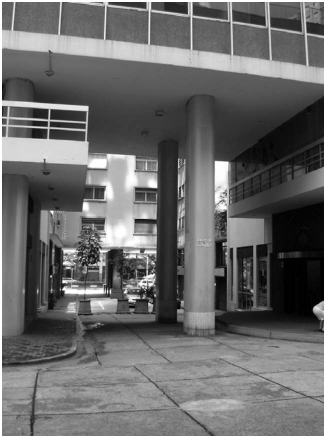
Edifício Vila Normanda São Paulo Passagem em pilotis para a av. São Luiz. Fonte: imagem do autor, 2008.
