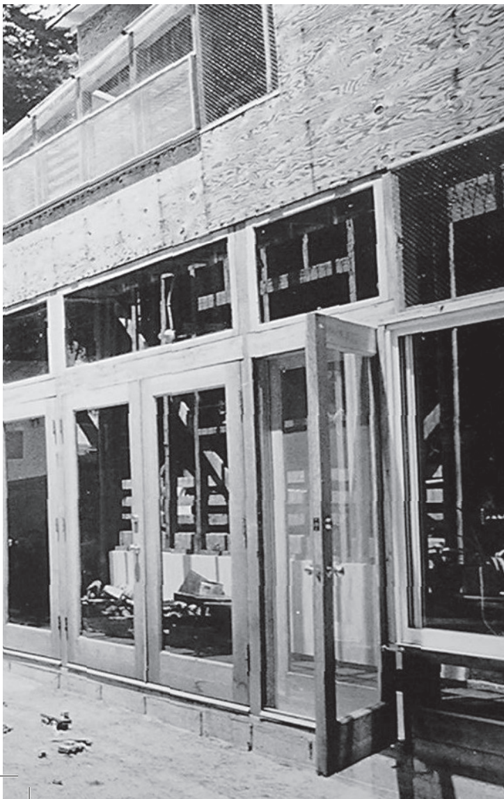
FIG. 131 Quintal da casa, com a nova fachada inserida sobre o antigo bangalô e o painel do muro que da para a rua.
