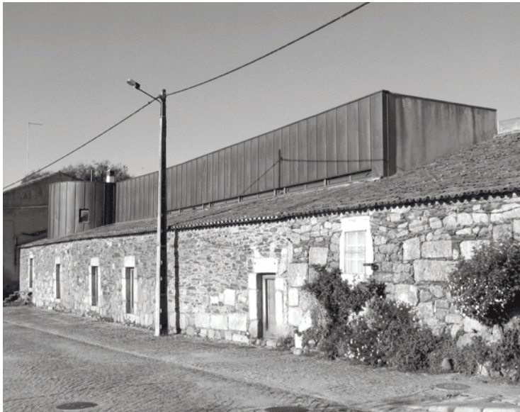
Fig. 262 O Palheiro de São Dâmaso com o volume metálico sobre a cobertura construído como referência a muralha ali existente.
