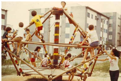
imagens 3_42 e 3_43. Mutirão de construção do Parquinho do Butantã, formado por designers, artesãos e moradores (Fonte - 42: ALMEIDA, 1997; 43: ALMEIDA, 1985)
