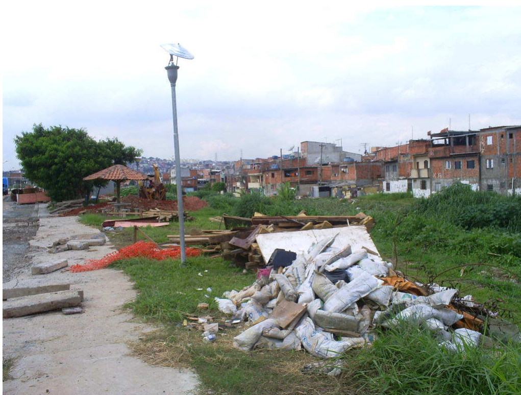
Figura 30 – O entulho gerado pela obra foi depositado na própria área verde, criando situações análogas àquelas observadas antes da intervenção, como indica as fotos acima. Fotos de 2008.
