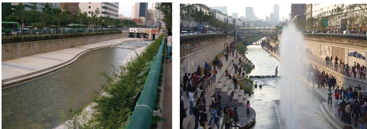
Figura 9 – Faixas impermeáveis ao longo do leito restaurado do rio.
