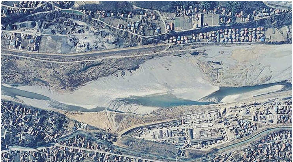
Figura 3 – Leito do rio Tama, em 1974. A exploração de cascalho do leito do rio ocasionou o desaparecimento da vegetação em suas margens.
