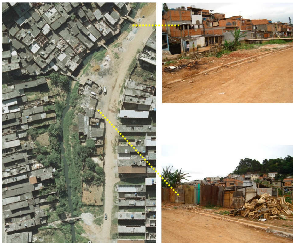
Figura 20 – Situação da Área de Preservação Permanente – vistoria realizada em outubro de 2006. À esquerda do curso d'água, ocupações localizadas no município de Carapicuíba – há trechos em que não há nenhuma faixa preservada. Toda a faixa da APP é cortada por pontes improvisadas, indicando o aspecto de obstáculo que o córrego representa para a comunidade local. No trecho localizado em Osasco (à direita do curso d'água), há alguns barracões – utilizados pelos moradores do município vizinho para criação de animais.
