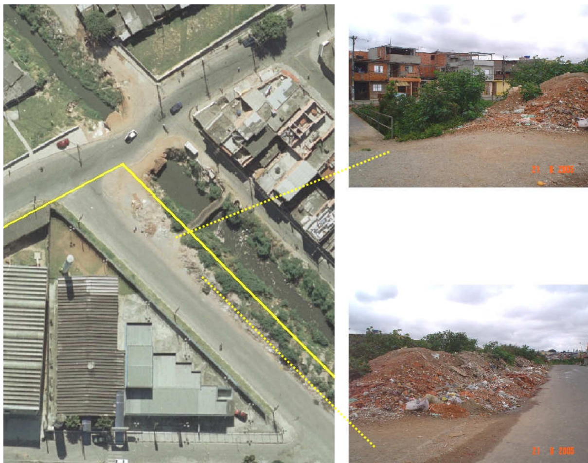
Figura 25 – Trecho da Área de Preservação Permanente do loteamento antes da intervenção realizada pela Prefeitura. As fotos mostram pequenas pontes que serviam de ligação com outros assentamentos. Observar a deposição de entulho. Fotos de 2005. Fonte: Prefeitura de Osasco / Secretaria de Habitação e Desenvolvimento Urbano
