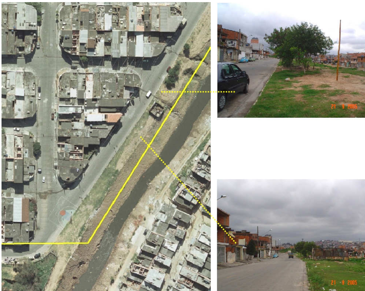
Figura 26 – Trecho da Área de Preservação Permanente do loteamento antes da intervenção realizada pela Prefeitura. As fotos mostram os poucos trechos planos antes da intervenção. Fotos de 2005.
