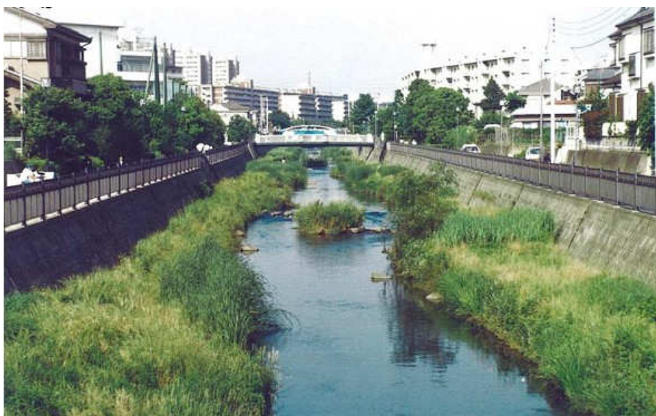
Figura 2 – Rio Itachi, após as obras de renaturalização. A utilização de sedimentos ao longo das margens permitiu um traçado meândrico para o curso d'água. Fonte: Nakamura; Tockner; Amano, 2006.
