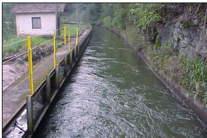
Figura 16: Canal de Adução.
