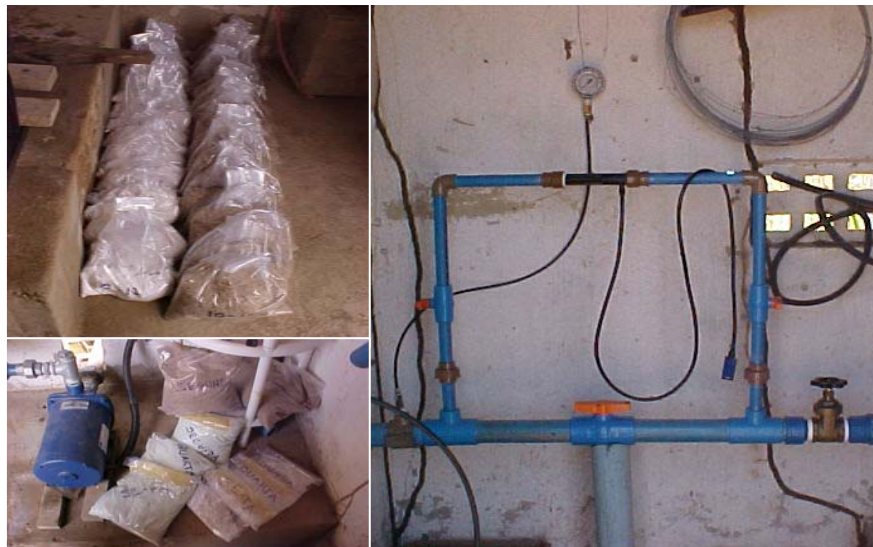
Figura 11 - Fertilizantes usados na fertirrigação e injetor de fertilizante, tubo Venturi. FEVC, Pentecoste, CE, 2007.
