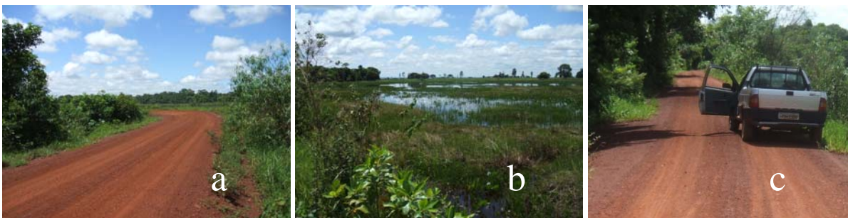
Fig.24 – P.A. Capão Bonito II: A) Curva em ângulo reto sobre aterro; B) O lago e brejos à margem do aterro C) largura estreita do aterro não permite o cruzamento de veículos médios e grandes.
