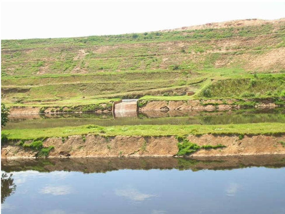
**Foto: Desenvolvimento de Processos Erosivos nos Taludes das Lagoas, (12/2005).**
