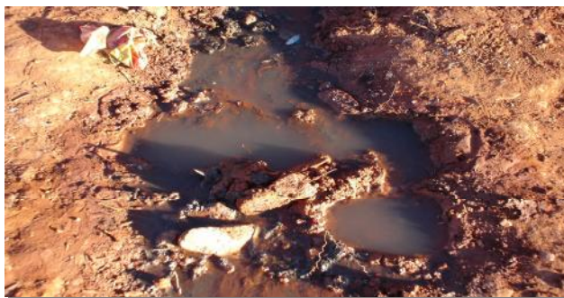
Foto 12 Esgoto a céu aberto - N. S. da Guia - Lafaiete
