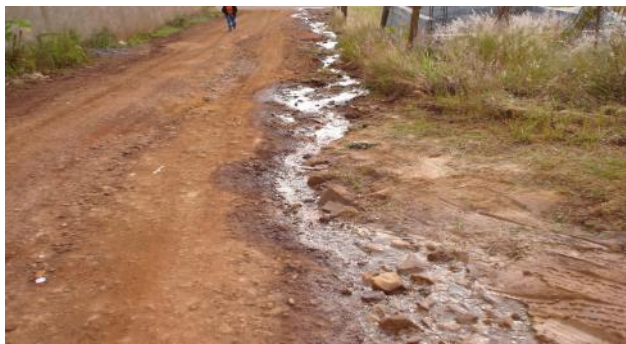
Foto 11 Esgoto a céu aberto - Pocinho
