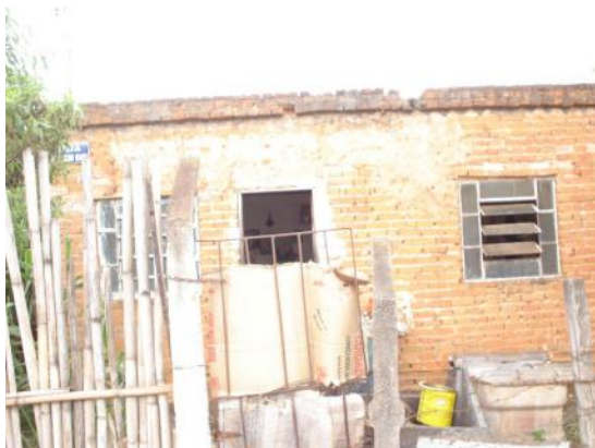
Foto 19 Construção domiciliar no Bairro Alvorada - Congonhas
