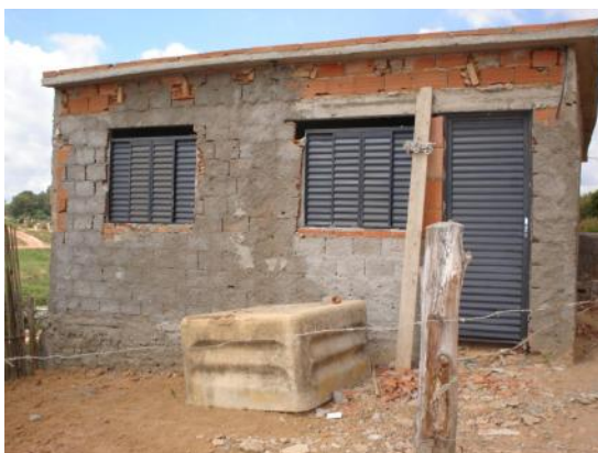
Foto 15 Casa em construção Bairro N. S. da Guia-Lafaiete
