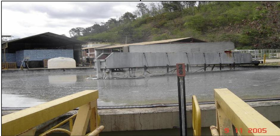
DECANTADOR PRIMÁRIO: REMOÇÃO DE SÓLIDOS / ADIÇÃO DE NUTRIENTES PARA AS PRÓXIMAS ETAPAS DO PROCESSO DE TRATAMENTO (N: P: K)
