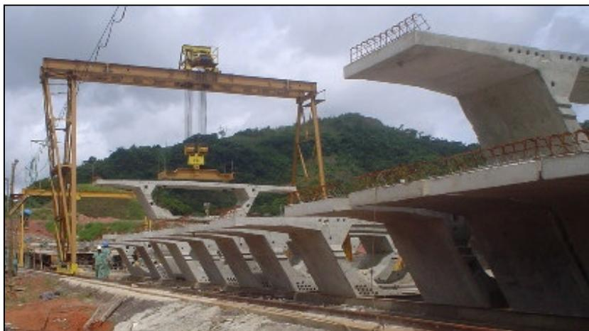
**FIGURA 22 – Movimentação de aduelas pré-fabricadas**
