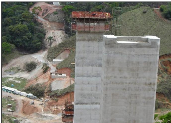
**FIGURA 23 – Topo dos pilares projetados para o lançamento das aduelas**
