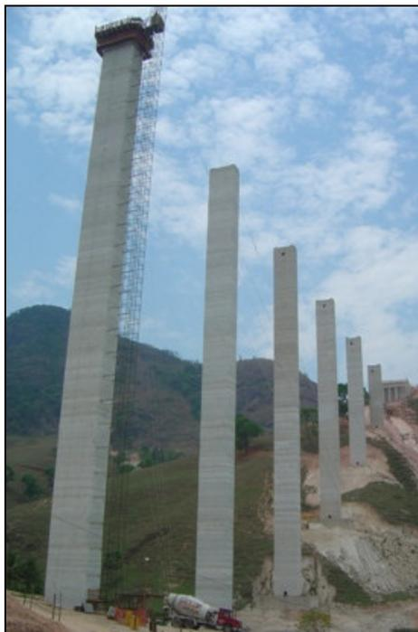
**FIGURA 24 – Execução dos pilares do viaduto**
