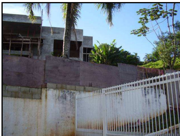
Figura 15. Casa em processo de edificação no Condomínio Casablanca Autora: Aline Schaefer Körbes. 05/04/2008
