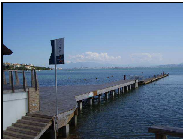
Figura 19. Trapiche localizado em frente ao St. Barth Residence
