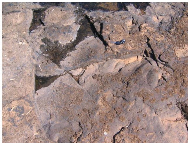
Figura 8.10. Bacia de arranque formada em soleira fluvial no trecho 34. Há parcial delimitação por planos de fratura e a superfície é irregular, sugerindo arranque de blocos induzido pelo impacto de clastos em trânsito.
