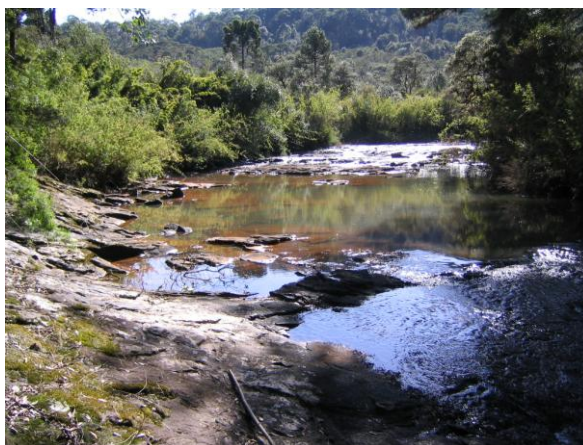
Figura 8.8. Vista parcial do trecho 32, onde se formam depressões por arranque de vários blocos poligonais.
