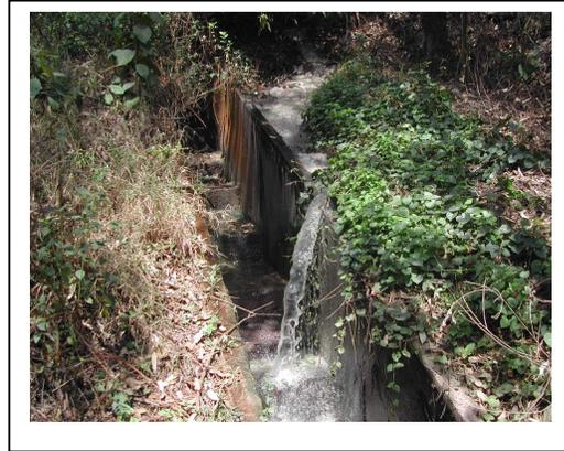
FIGURA 4.2 Registro fotográfico do lançamento do esgoto da UFOP no canal receptor de águas pluviais.
