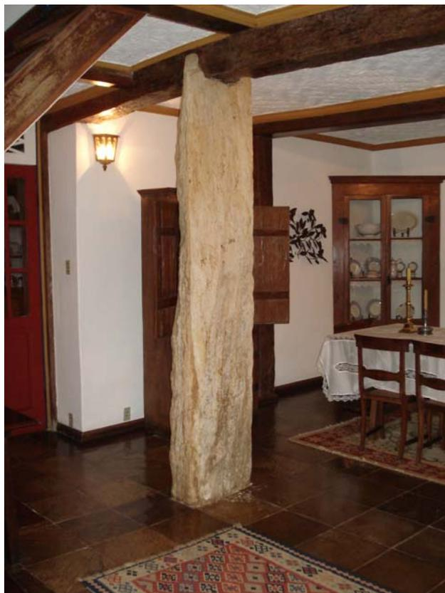
**Figura 25 – Coluna de quartzito em porão de residência particular**
