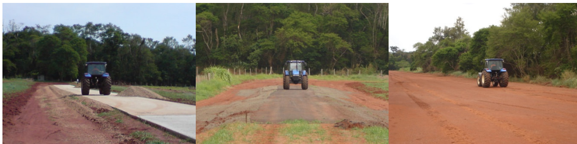
Figura 7 – Pistas de concreto, asfalto e solo firme, respectivamente.
