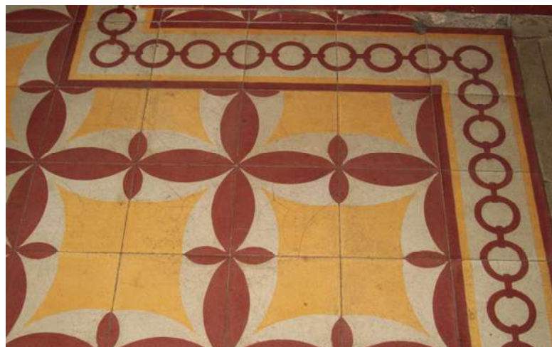
Figura 75 Piso da nave principal da igreja.
