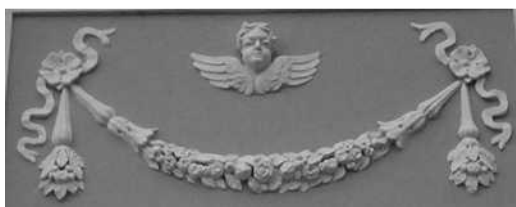
Figura 72 Guirlanda na fachada da igreja de São Luiz do Gonzaga
