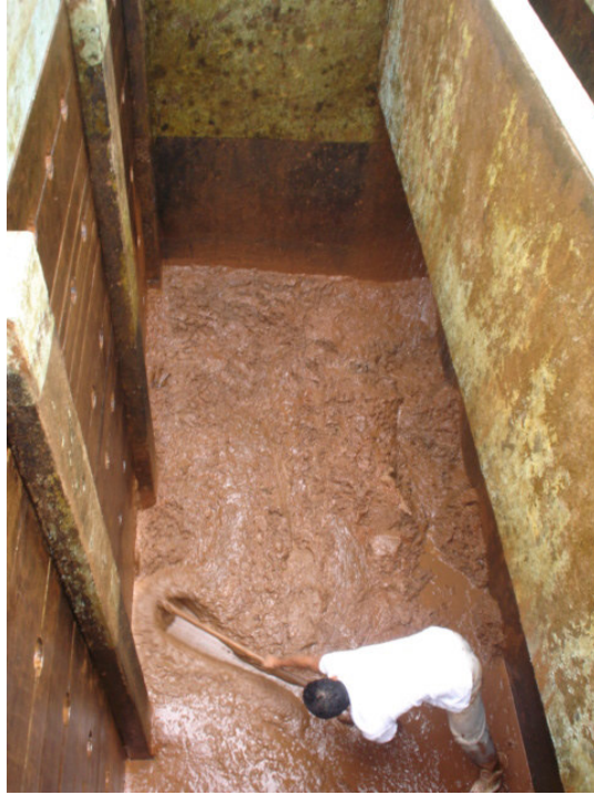
Figura 36: Ação do operador na raspagem do lodo entre a cortina de distribuição e as paredes do decantador
