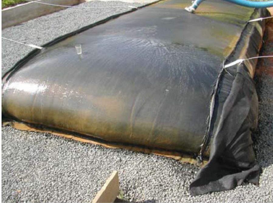
Figura 15: Unidade de geotêxtil com o lodo da ETA de Santo Antônio do Jardim, São Paulo
