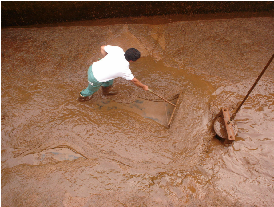
Figura 5: Contato operador-lodo na operação de raspagem do lodo da ETA-Itabirito
