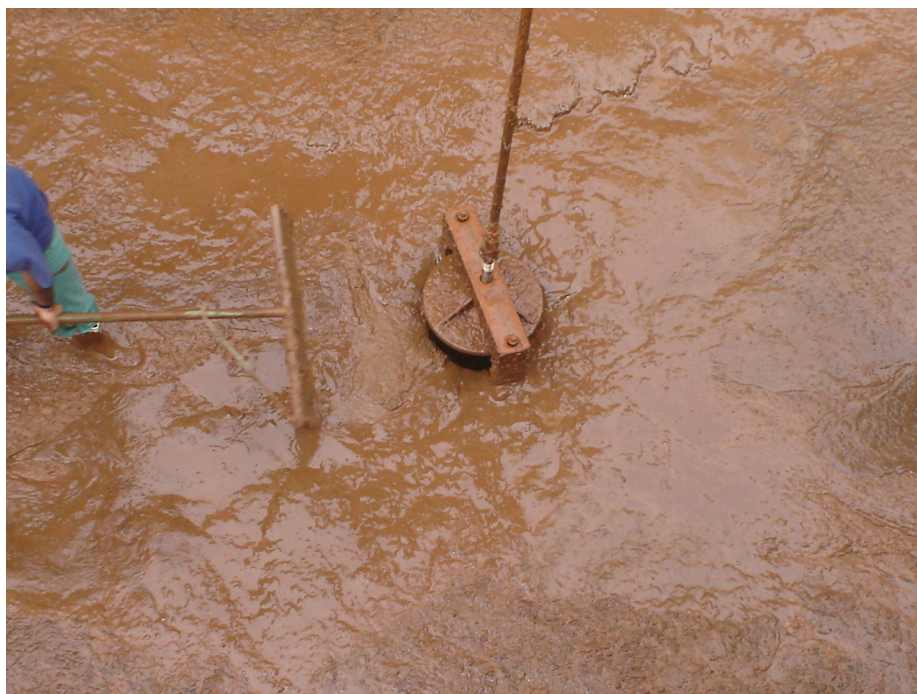
Figura 22: Região 1 - Centro do decantador (adufa de fundo) – Ponto de descarga
