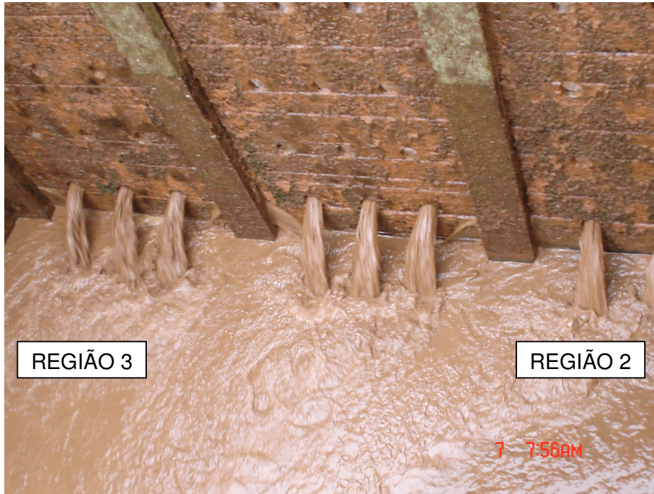
Figura 23: Regiões 2 e 3, pontos de coleta de lodo no decantador
