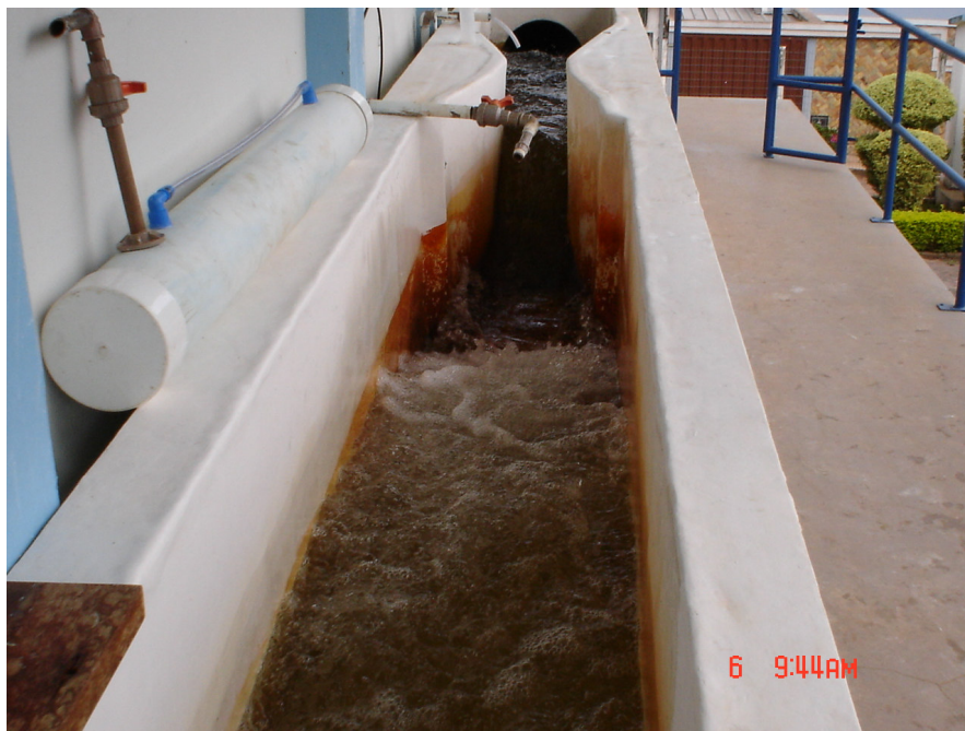
Figura 18: Calha Parshall da ETA-Itabirito
