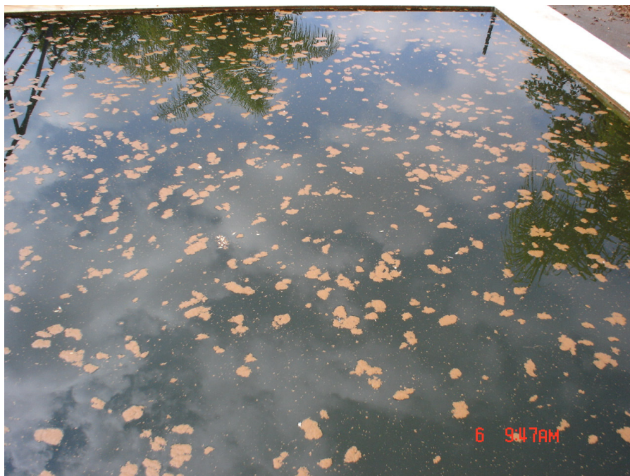
Figura 56: Arraste de flocos não decantados para os filtros da ETA-Itabirito
