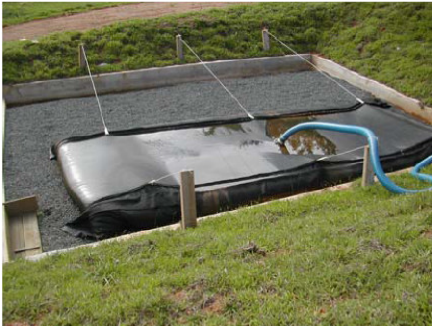
Figura 14: Implantação de uma unidade de geotêxtil na ETA de Santo Antônio do Jardim, São Paulo
