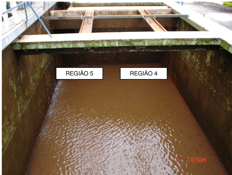
Figura 24: Regiões 4 e 5, pontos de coleta de lodo no decantador
