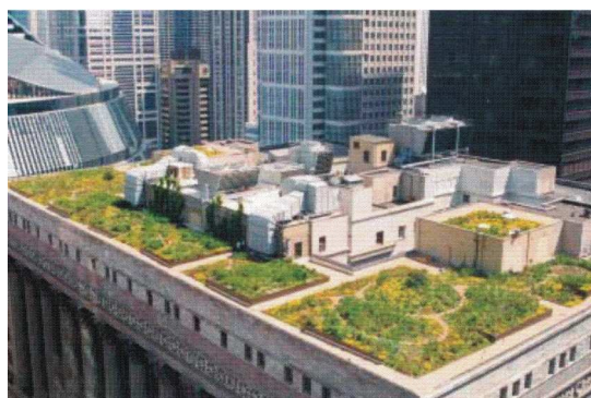
Figura 12: Telhado Verde na cobertura da Prefeitura de Chicago.
