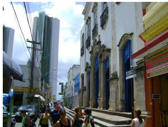
Foto 80 - Vista da Igreja de São José do Ribamar. Fonte: Raphael Melo (fev./2009).
