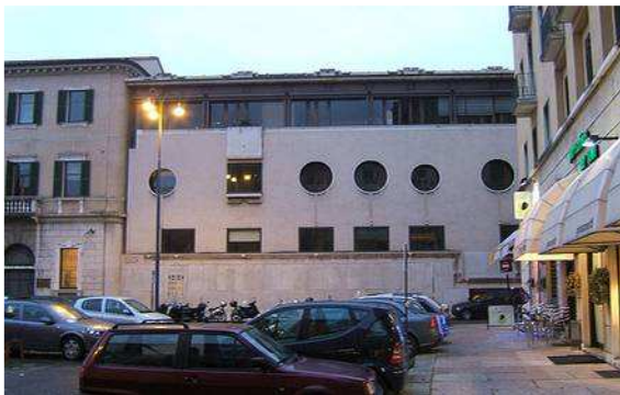
Figura 33 - Edifício da Banca Popolare di Verona , de Carlo Scarpa - Verona/1973.
