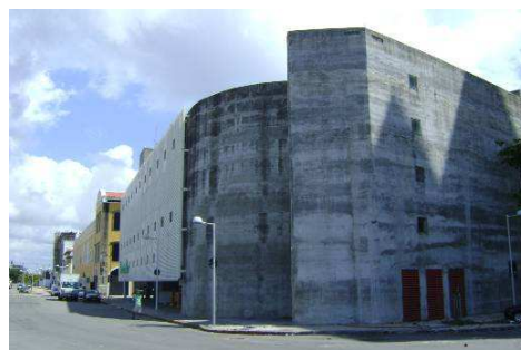
Figura 65 - Fachada sul trabalhada em concreto aparente.
