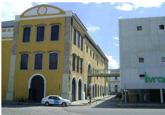
Figura 74 - Passarela que conecta o edifício-garagem ao shopping . Fonte: Raphael Melo (fev./2009).
