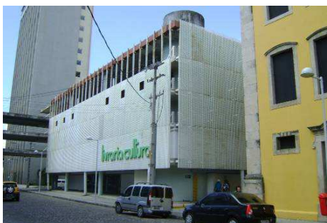
Figura 64 - Chapa metálica utilizada na vedação da fachada.
