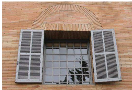
Figura 36 - Detalhe dos tijolos aparentes que remetem ao sistema construtivo tradicional.
