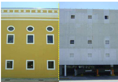
Figura 62 - Comparação entre as aberturas do Shopping Paço Alfândega e as dos edifícios-garagem.
