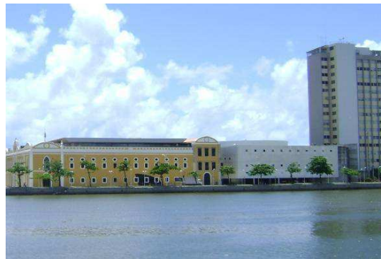
Figura 59 - Edifício-garagem situado ao lado da antiga Alfândega, que foi transformada em shopping center. Fonte: Raphael Melo (mar./2009).
