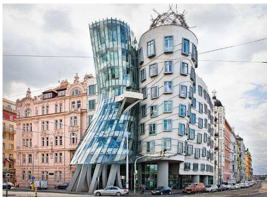
Figura 29 - A Casa Dançante de Frank Gehry é um exemplo nítido da ruptura formal com os edifícios adjacentes - Praga/1995.
