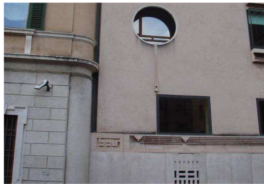
Figura 34 - Detalhe da junção entre o edifício novo e o antigo.
