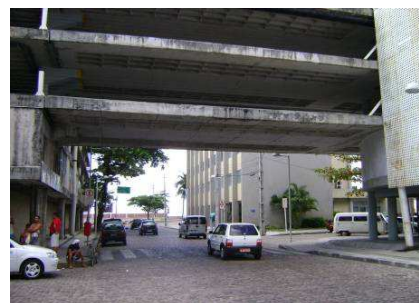
Figura 61 - Passarelas construídas sobre a Rua Madre de Deus.
