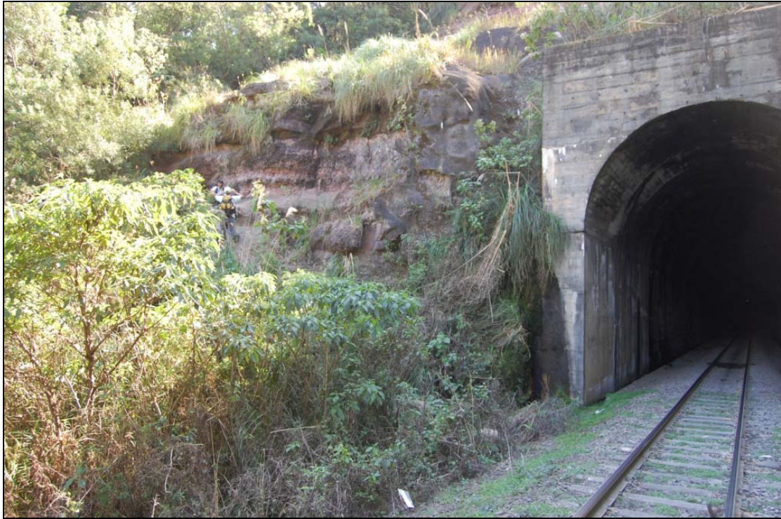
Figura 22 – Localidade ‘Tubarão’. Afloramento localizado a margem da ferrovia EFCP, ao lado da boca sul do túnel do km 500,2.
