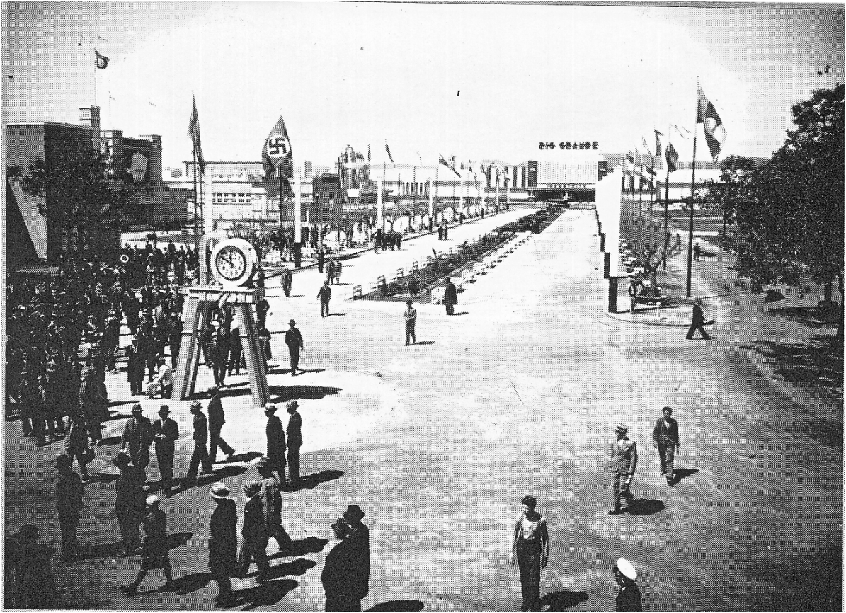
Fotografia 16: Vista do eixo Monumental Foto: Olavo Dutra Acervo: Faculdade de Arquitetura da UFRGS
