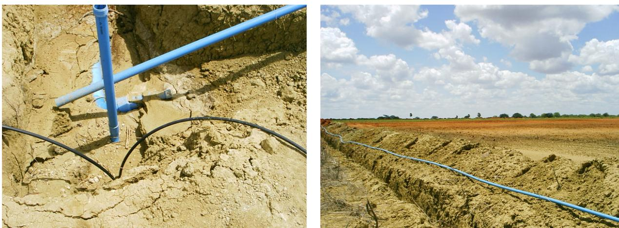
Figura 1. Ramificação da tubulação principal para a irrigação do experimento, instalado paralelamente
