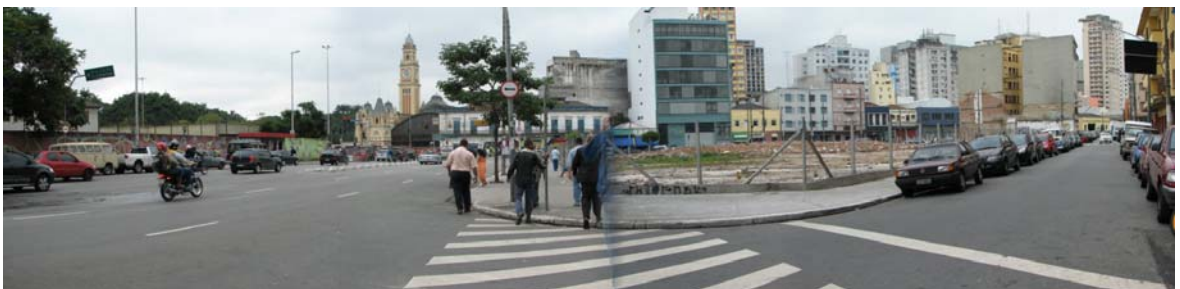
FIGURA 18: Quadra na região da Luz demolida, a partir das propostas do "Programa Nova Luz". Imagem de dezembro de 2008.
