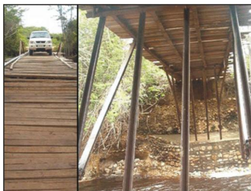
PA Baixão: Ponte construída pelos assentados. Foto: Paulo Coqueiro / 2006.
