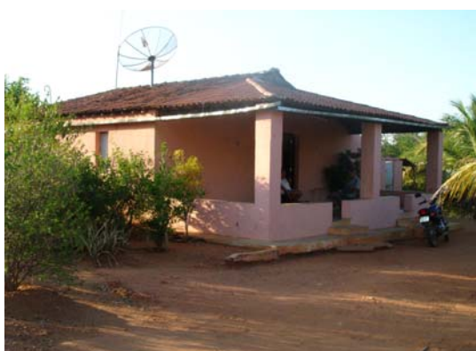
Foto 18 - Residência de Francisco Inácio
