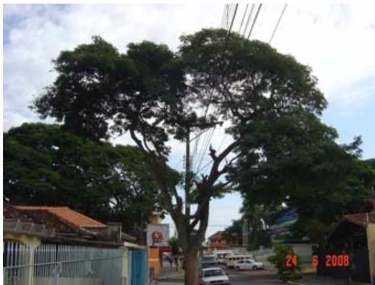
Figura 2.6: Rede de distribuição passando no meio da árvore.
