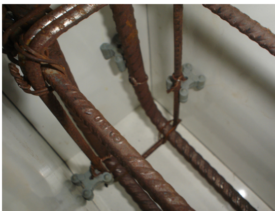
Figura 3.17 – Detalhe dos espaçadores para garantia do cobrimento das armaduras.
