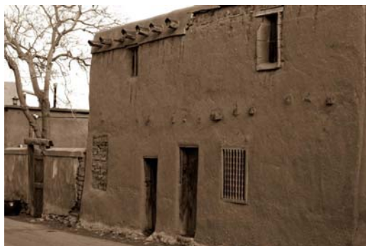
Figura 2.26 – Casa construída no ano de 1540: adobe reforçado com palha (Fonte: IMAGEM, 2008).
