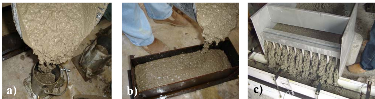
Figura 3.18 – Moldagem com CAA: a) corpos-de-prova cilíndricos; b) prismas; e c) viga armada.
