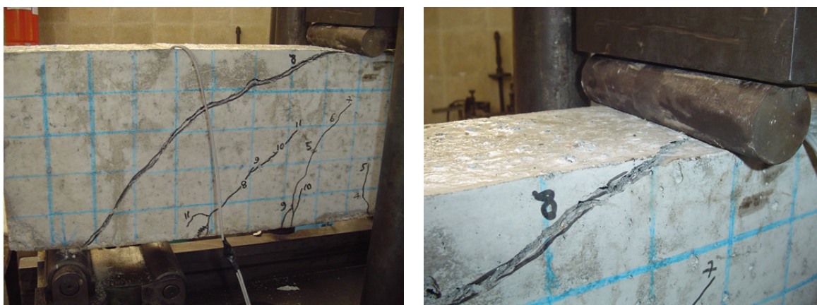
Figura 4.19 – Detalhe de fissura na ruptura da viga produzida com o CREF.
