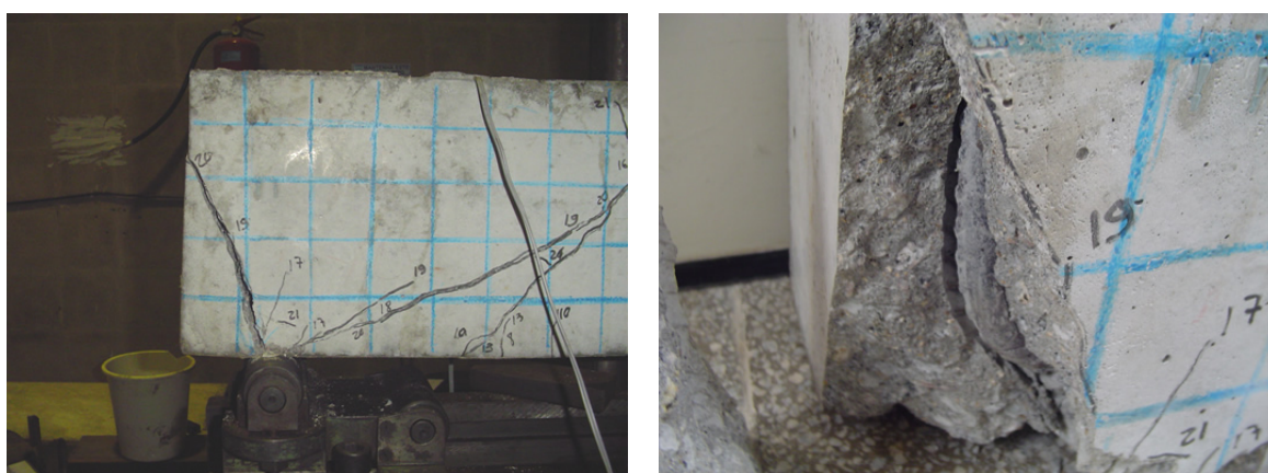
Figura 4.15 – Verificação da falha de ancoragem da armadura longitudinal na viga produzida com CAA.
