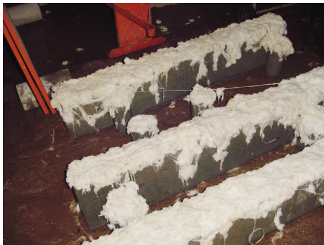
Figura 3.21 – Cura das vigas por molhagem.
