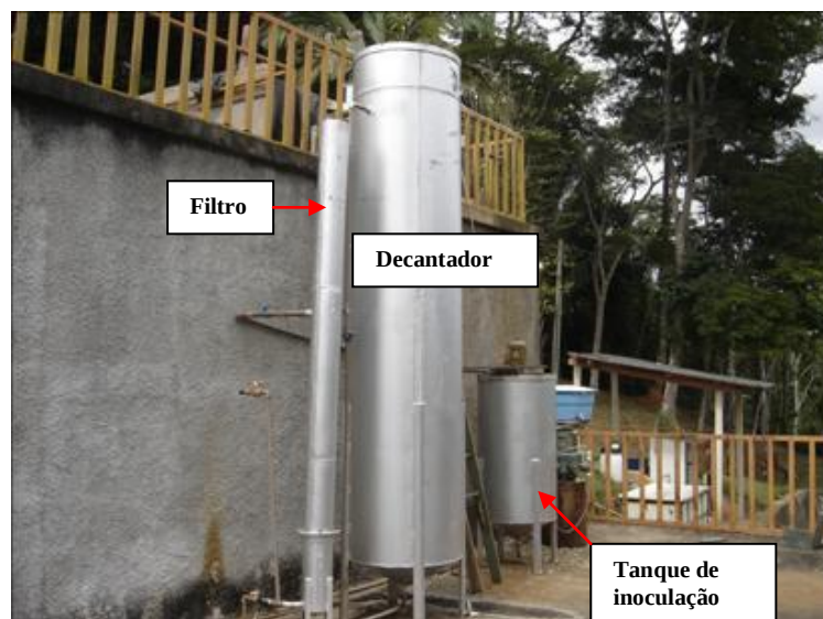
Figura 10 – Vista parcial da ETA piloto, decantador, filtro e tanque de inoculação de oocistos de Cryptosporidium .
