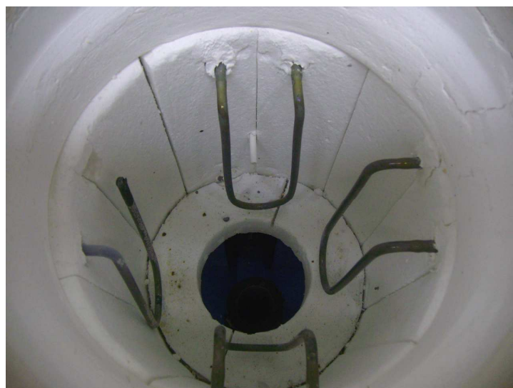
Figura 4.3. Vista do interior da câmara quente.
