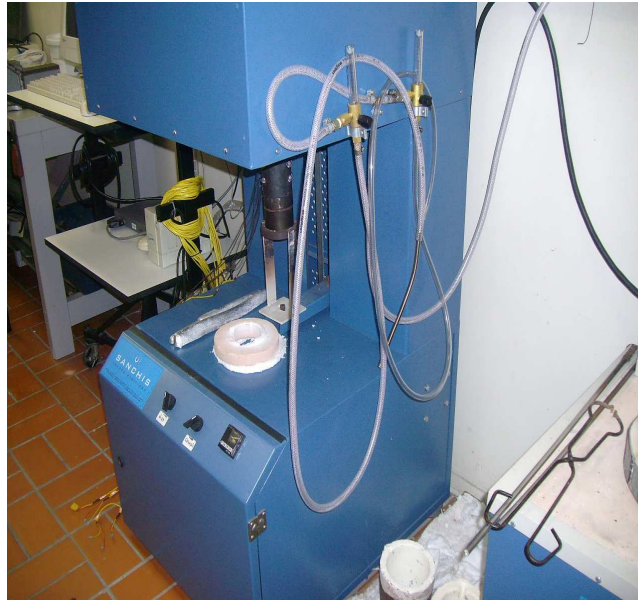
Figura 4.7. Detalhe da instalação dos rotômetros.
