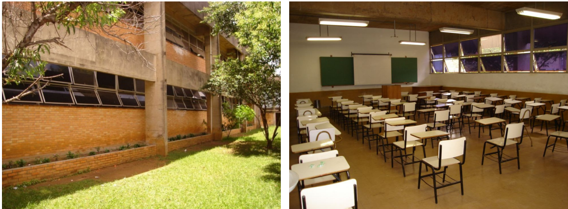
Figura 3.15 – Fachada leste do ICEB1 e sala de aula.
