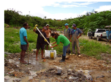
Figura 29.3 - Poço potencialmente contaminado (Am-02), escavado em maio de 2007.
