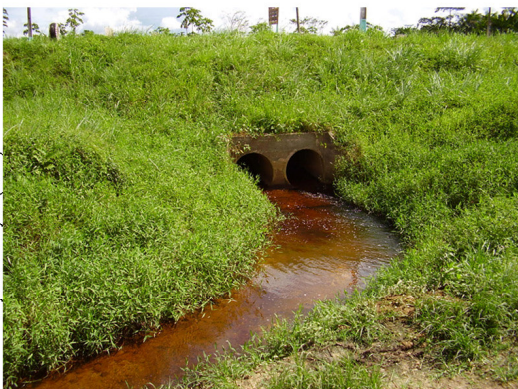
PONTO-05 - Sede de Santa Luzia do Pará (rio Curizinho)
