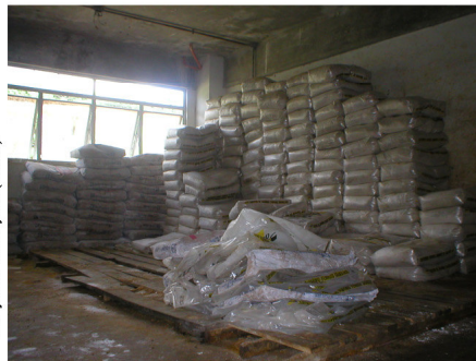
Figura 28.8 - Acondicionamento precário dos produtos químicos utilizados no tratamento da água (ETA de Bragança).
