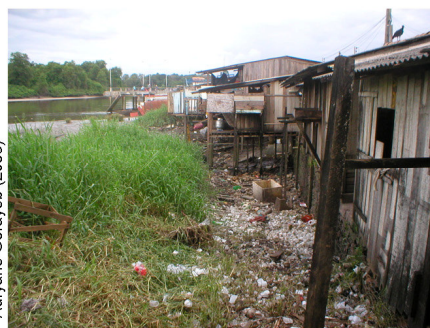
Figura 20.3 - Detalhe dos fundos das construções da feira de Bragança, com acúmulo de lixo nas margens do rio Caeté.
