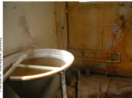
Figura 28.9 - Cone de saturação, onde é feita a fluoretação da água (ETA de Bragança).
