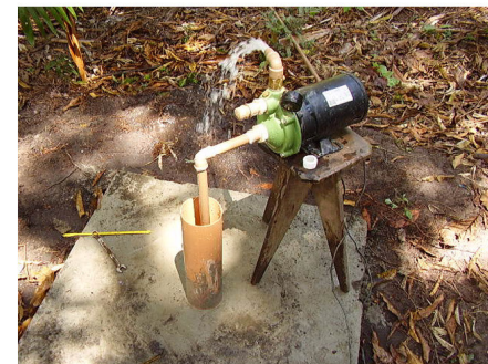
Figura 29.1 - Poço controle (Am-01) na comunidade do Rocha.
