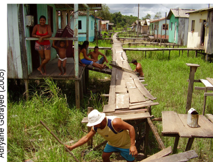
Figura 14.6 - Bairro de palafitas, construído com madeira reaproveitada de antigas embarcações, às margens do rio Caeté.
