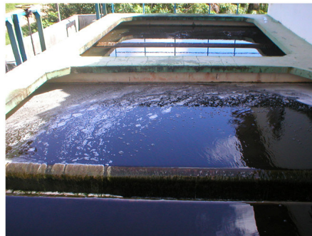
Figura 28.7 - Em destaque a água em processo de decantação (ETA de Bragança).
