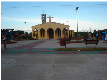
Figura 14.1 - Igreja Matriz de Santa Luzia do Pará, recém-reformada.
