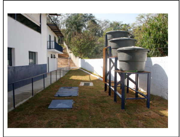
Figura 6.31b - Caixa de armazenamento e filtragem da água
