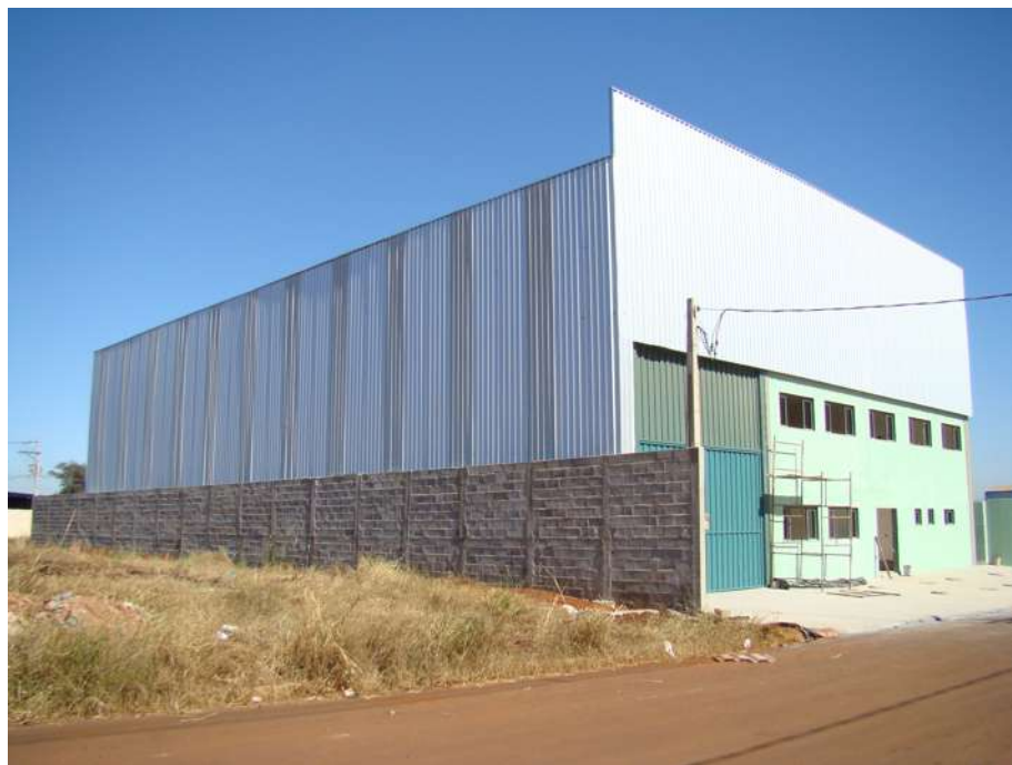
Foto 5.3 – Instalação industrial em fase final de construção.
