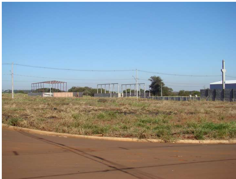
Foto 5.2 – Vista parcial do Distrito Industrial II.
