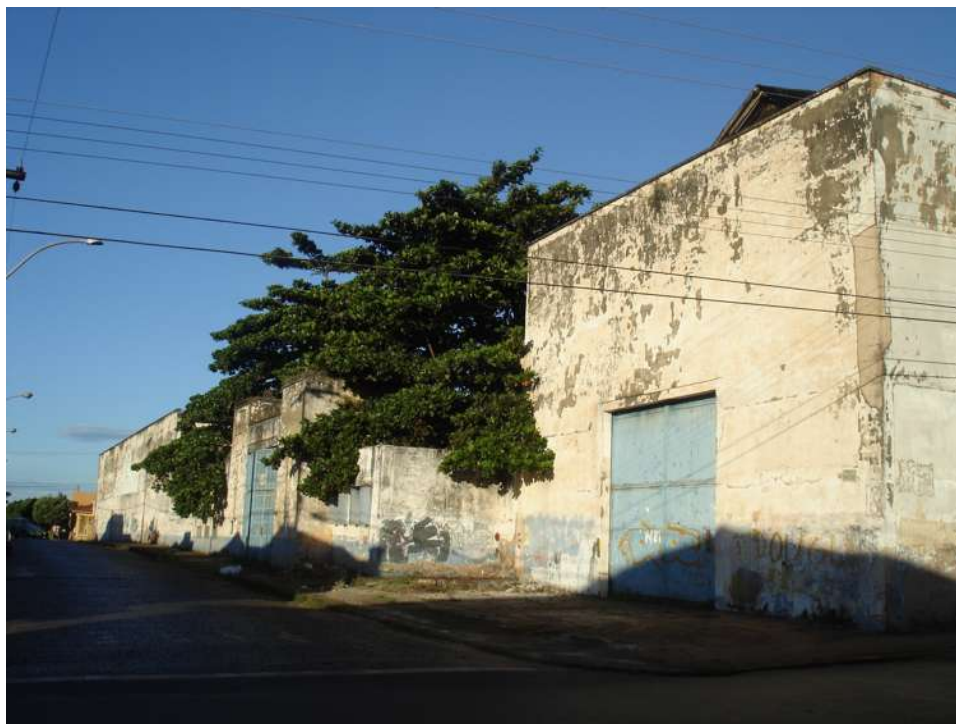
Foto 2.4 – Antigo prédio da Zanini, localizado na área central da cidade.
