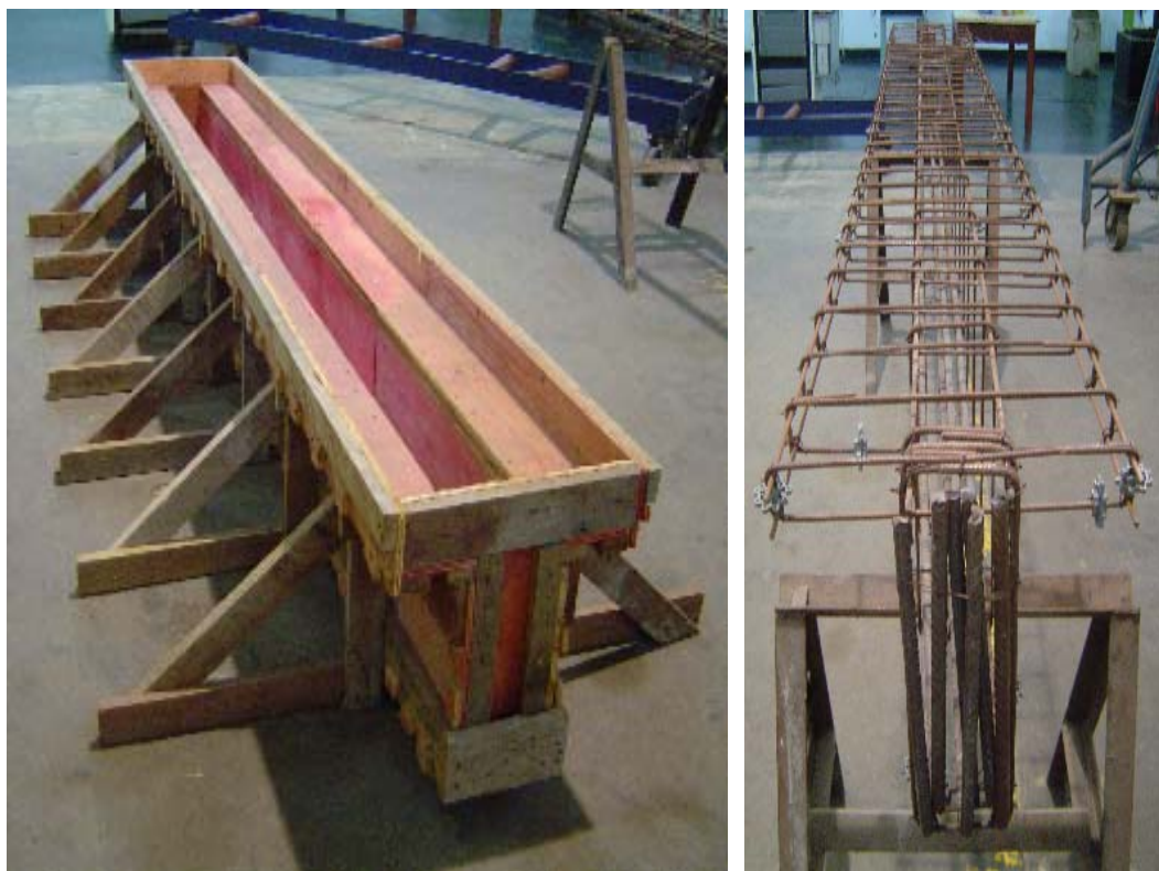
Foto A.8 – Formas e armaduras.
