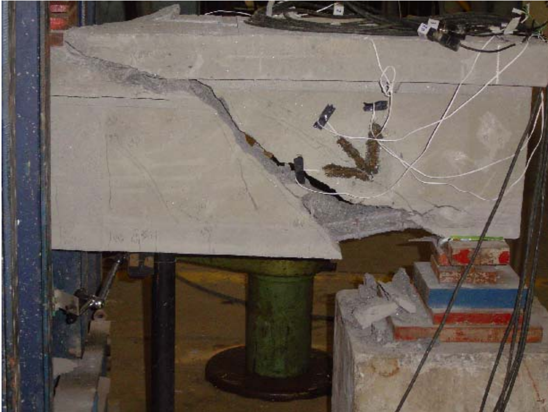
Foto A.21 – Detalhe da ruptura da viga VR1 (1).
