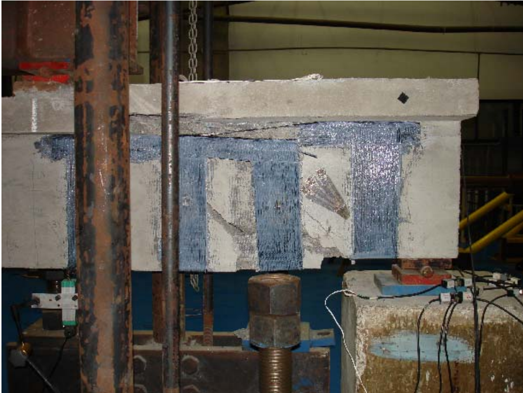
Foto A.25 – Detalhe da ruptura da viga VI-2 (1).
