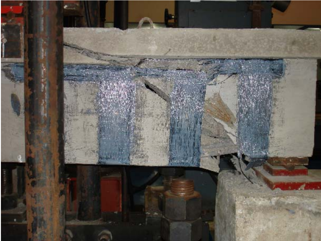
Foto A.23 – Detalhe da ruptura da viga VI-1 (1).
