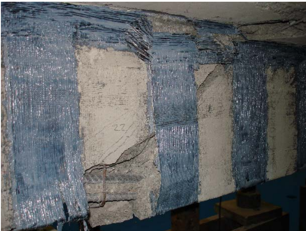
Foto A.24 – Detalhe da ruptura da viga VI-1 (2).
