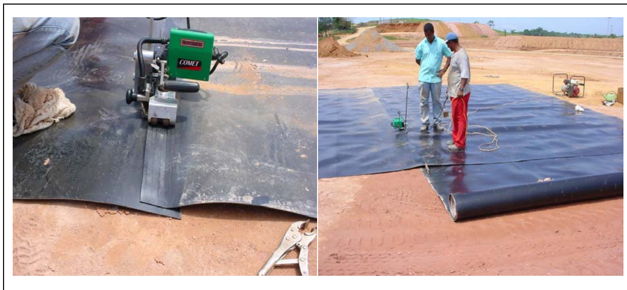
Fig. 3.19 – Soldagem da manta
