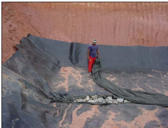
Fig. 3.18 – Cobertura do dreno
