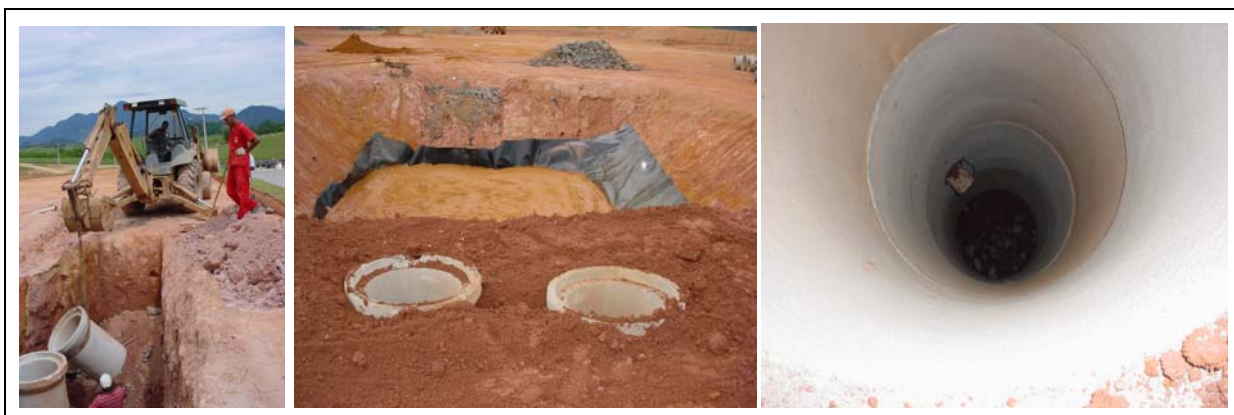
Fig. 3.23 – Construção dos poços de monitoramento e de acúmulo de percolado
