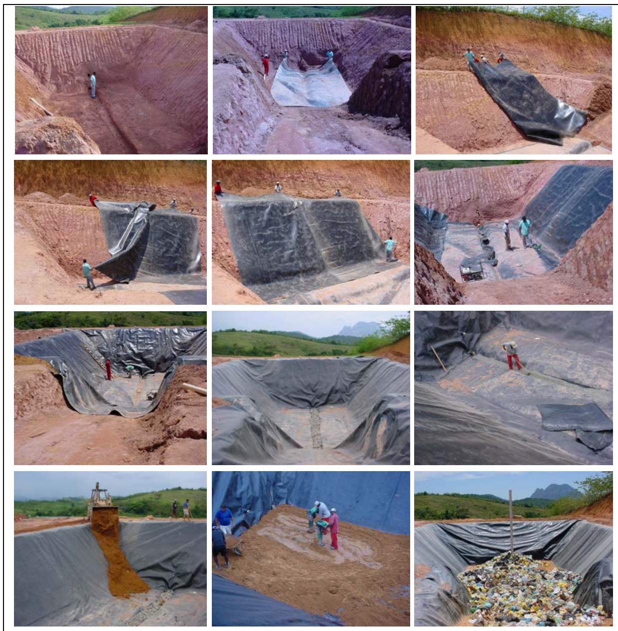
Fig. 3.17 – Seqüência de impermeabilização da CISC
