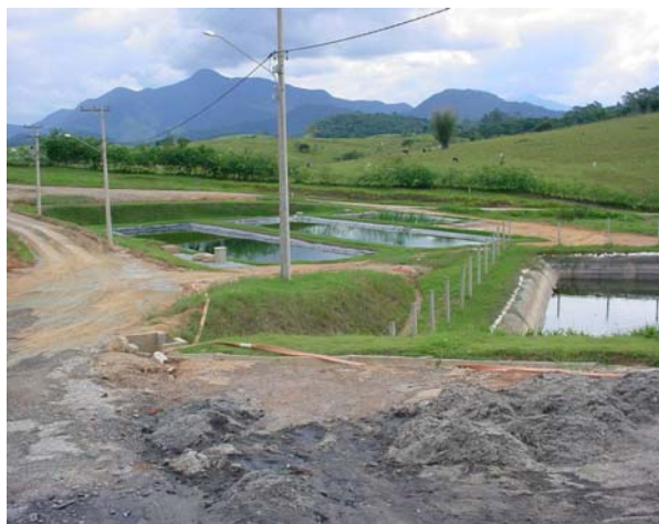
Fig. 3.11 – Lagoas de estabilização
