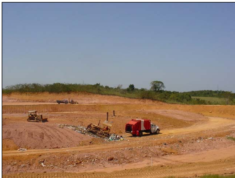
Fig. 3.12 – Frente de trabalho do Aterro Sanitário
