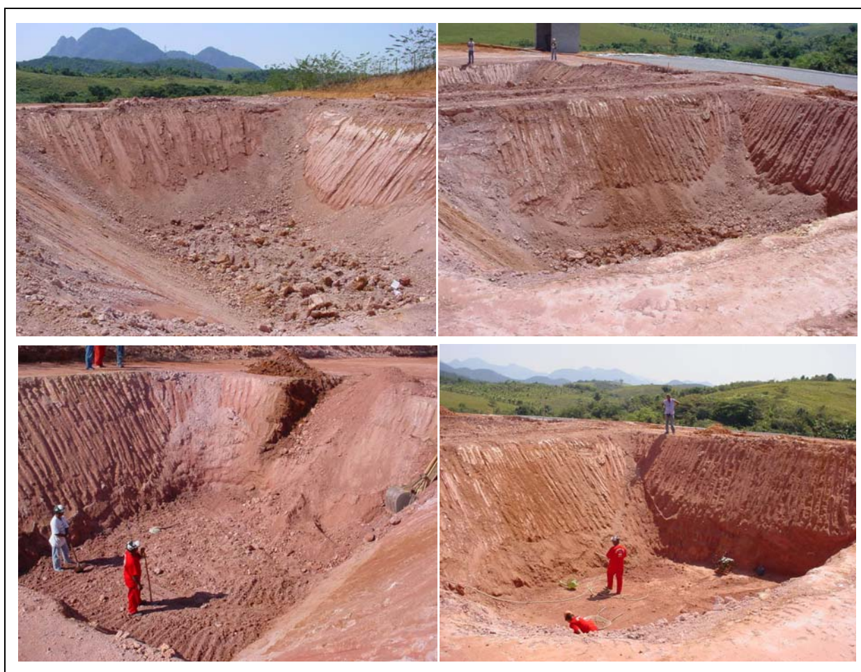
Fig. 3.13 – Escavação e limpeza das células
