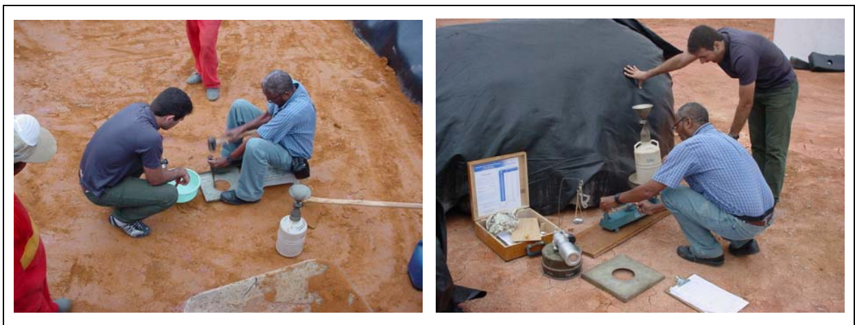
Fig. 3.22 – Acompanhamento técnico da compactação
