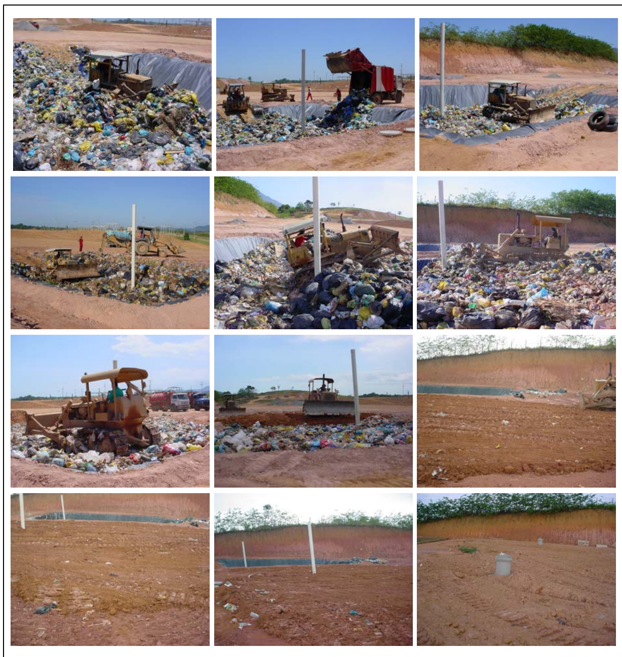
Fig.3.25 – Processo de enchimento e fechamento da célula
