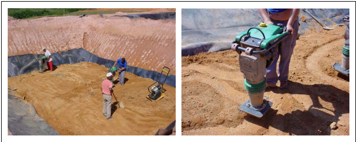
Fig. 3.21 – Compactação com o “sapo”
