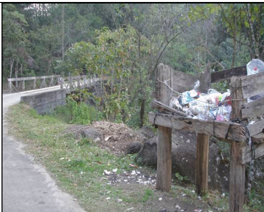
Foto 40: Coletor de lixo na beira do Rio Preto (que passa embaixo da ponte, à esquerda)
