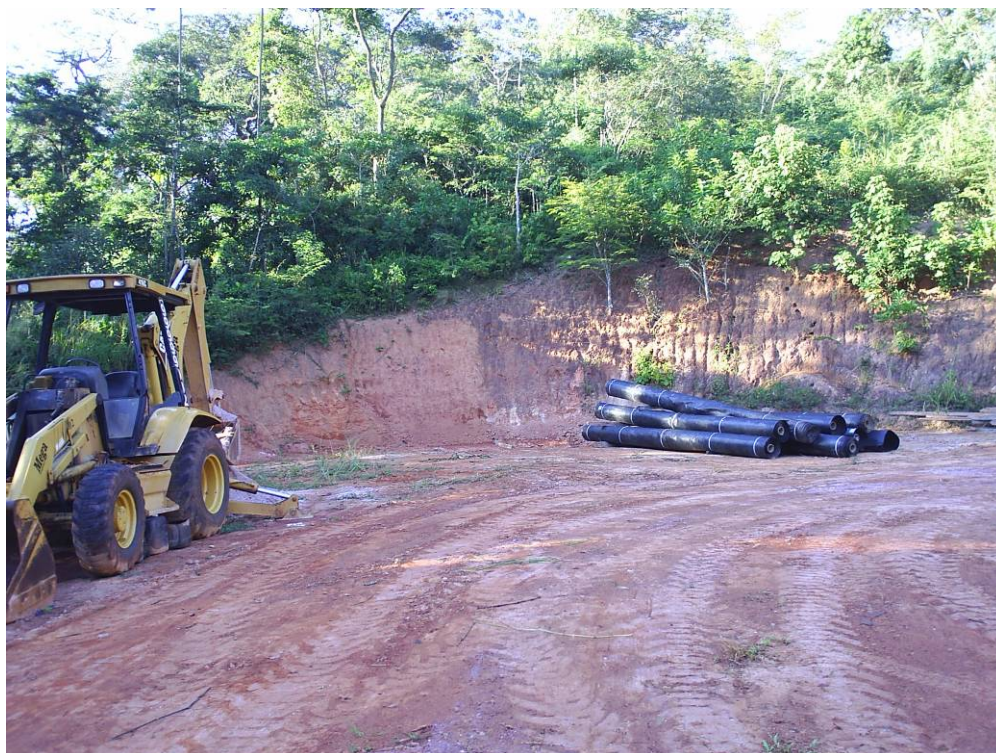
Figura 19 - Detalhe das geomembranas de PEAD e de maquinário em repouso.
