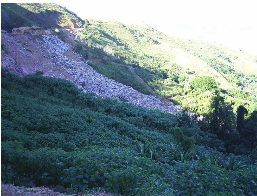
Figura 12 - Vista geral do vazadouro onde é possível observar o resultado do deslizamento dos resíduos destinados, ocorrido meses antes.
