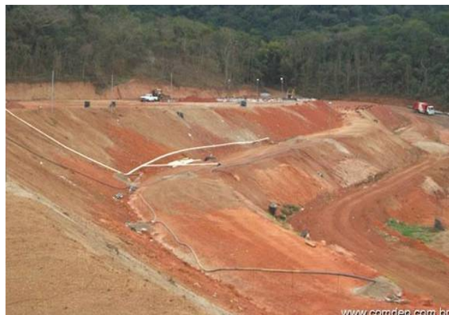
Figura 4 - Exemplo de aterro controlado: Petrópolis. Fonte: Comdep, 2008.
