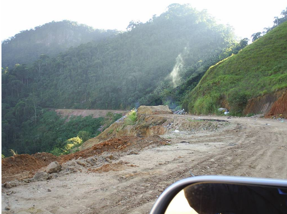
Figura 11 - Vista geral da entrada do vazadouro: a estrada de acesso atravessa a área onde os resíduos são lançados.
