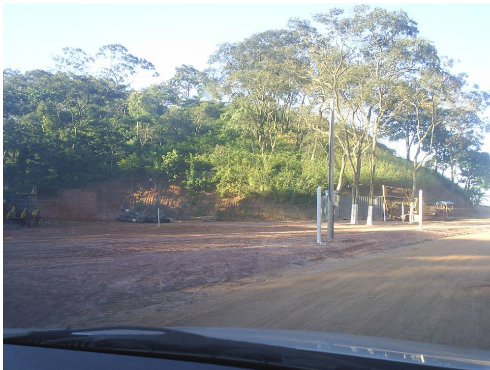
Figura 18 - Entrada do futuro aterro. Ao fundo é possível observar as geomembranas de PEAD (polietileno de alta densidade).
