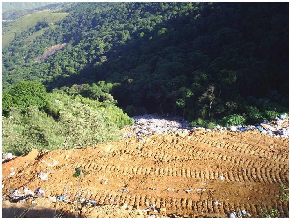
Figura 13 - Detalhe dos resíduos que foram deslocados durante o deslizamento ocorrido meses antes.
