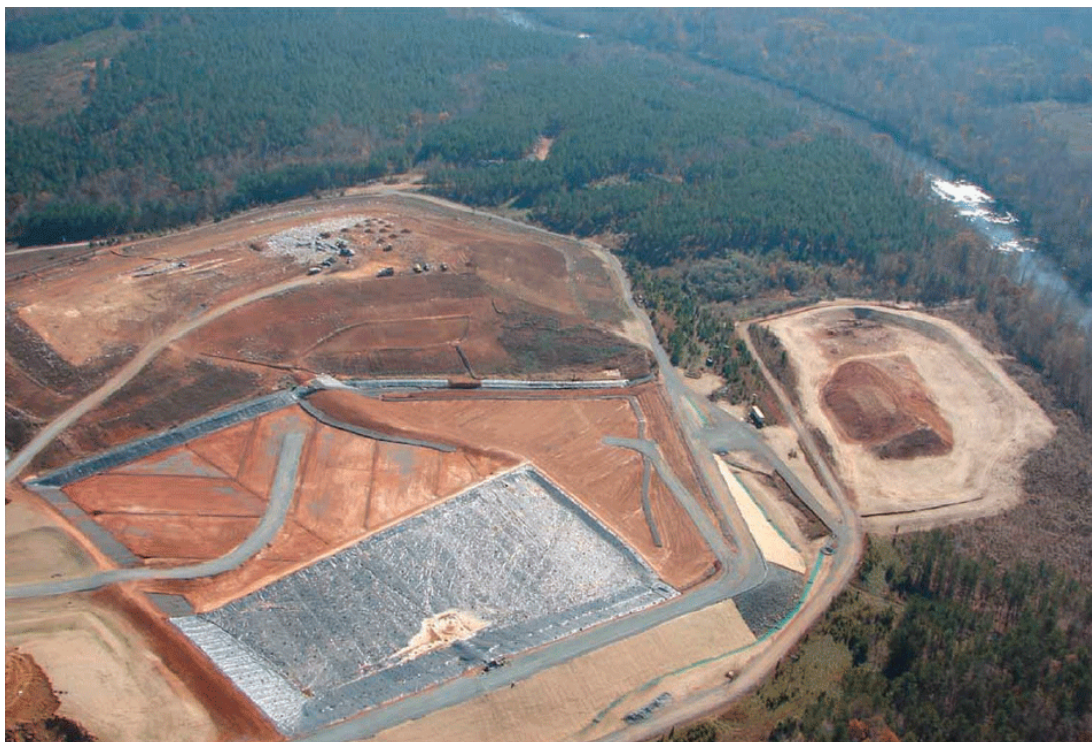
Figura 6 - Exemplo de aterro sanitário. Fonte: EWS, 2008.
