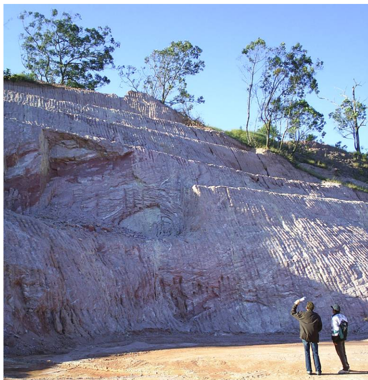
Figura 21 - Detalhe da principal área do aterro sanitário.
