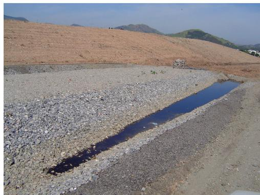
Figura 24- Infiltração de chorume com a galhada
