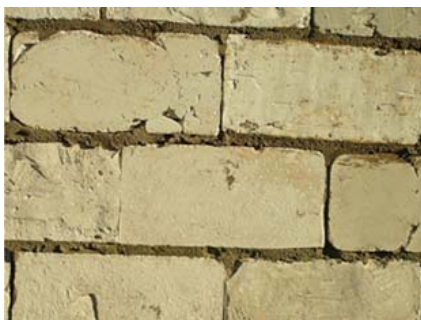
Foto 4.1 – Aspecto da parede de bloco maciço de gesso reciclado.
