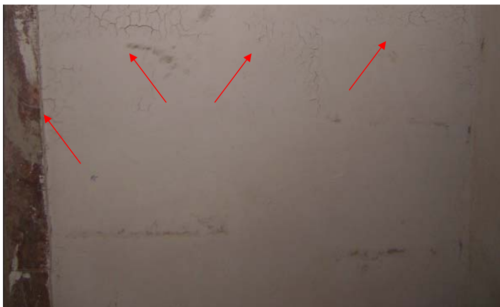
Foto 6.3 – Revestimento 50% RS na Parede B (AT), regularizado a superfície.
