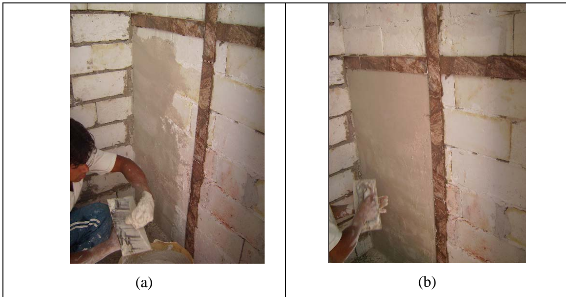
Foto 5.22 – Execução revestimento interno 100% RS na alvenaria de gesso cola.
