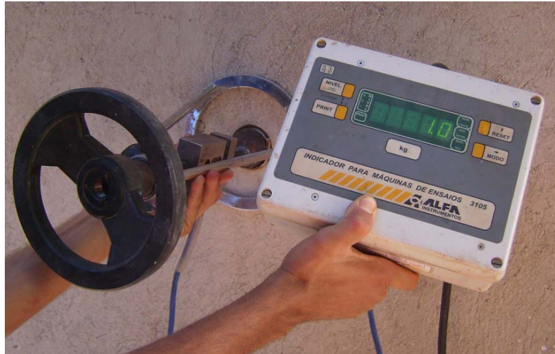
Foto 5.18 – Execução do ensaio de determinação da resistência de aderência à tração.
