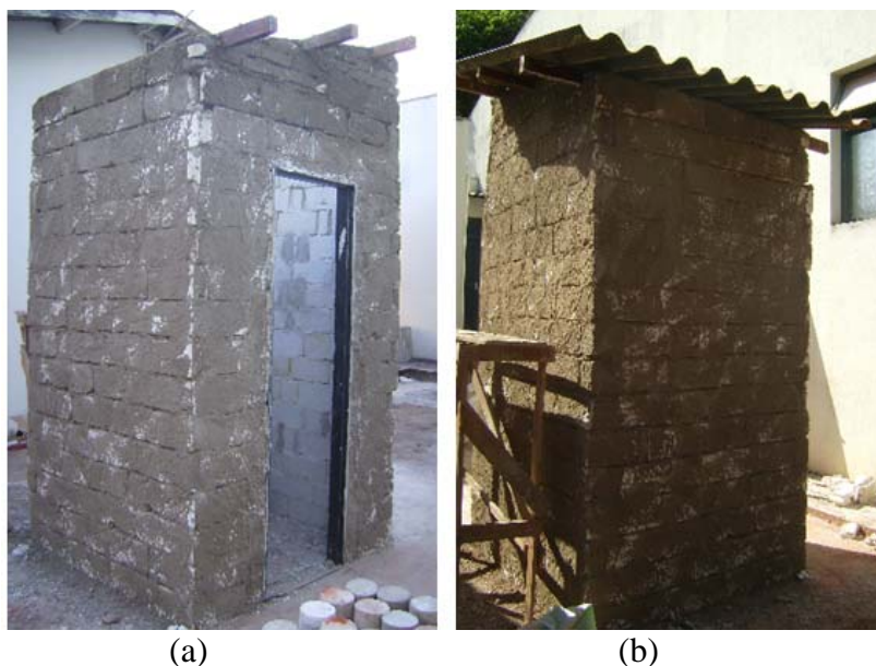
Foto 5.11 – (a) Protótipo chapiscado sem cobertura. (b) Protótipo chapiscado com cobertura.
