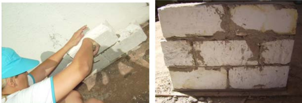
Foto 5.15 – Construção paredes em modelo reduzido.
