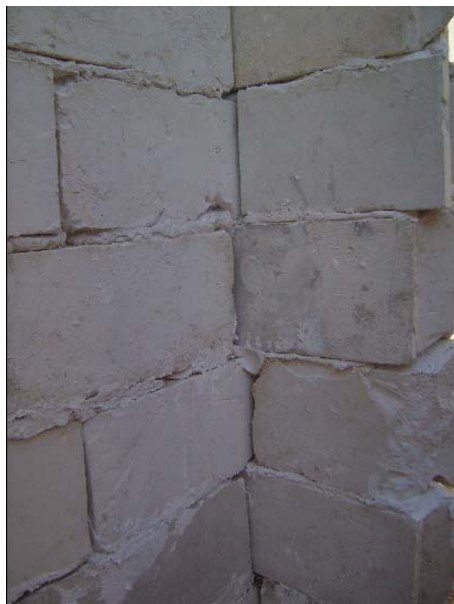
Foto 5.6 – Encontro alvenarias de gesso com assentamento de gesso cola (GC).
