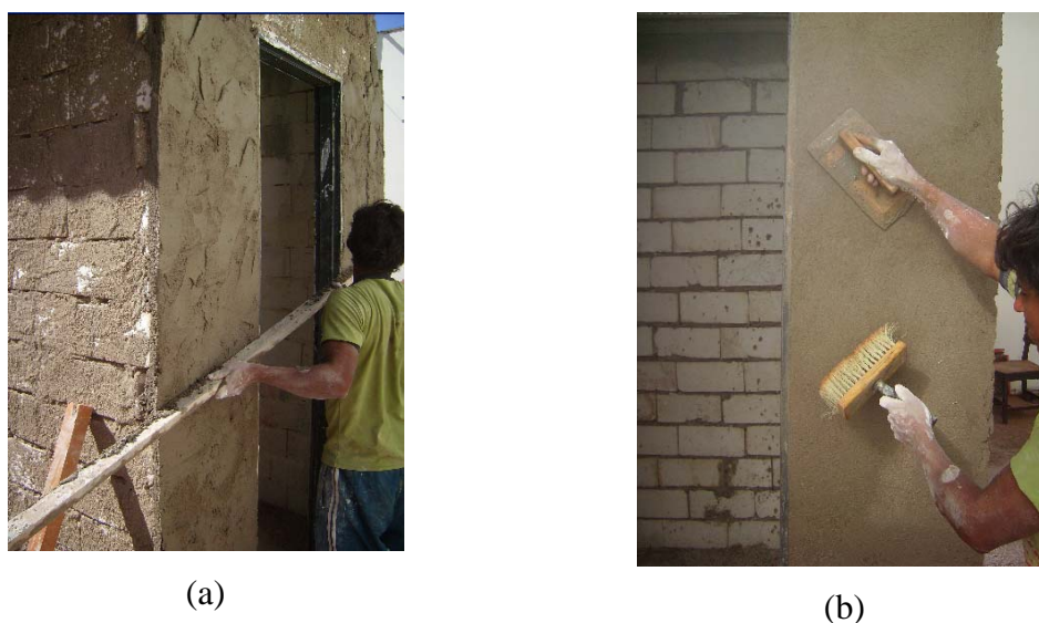
Foto 5.12 – Execução do reboco externo (a) Sarrafeamento. (b) Acabamento.
