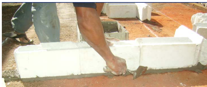
Foto 5.7 – Assentamento da primeira fiada de argamassa tradicional (AT).
