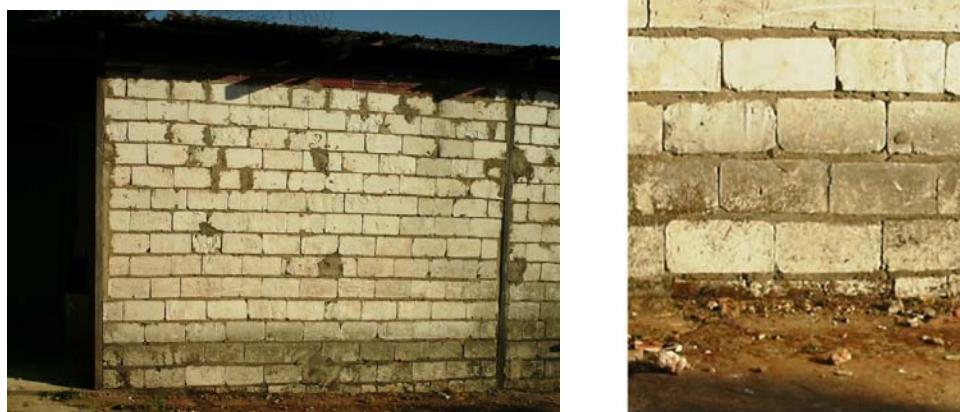
Foto 4.2 – (a) Parede de Bloco Maciço de Gesso Reciclado com 5 anos de idade (b) Parte inferior da Alvenaria de Gesso Reciclado
