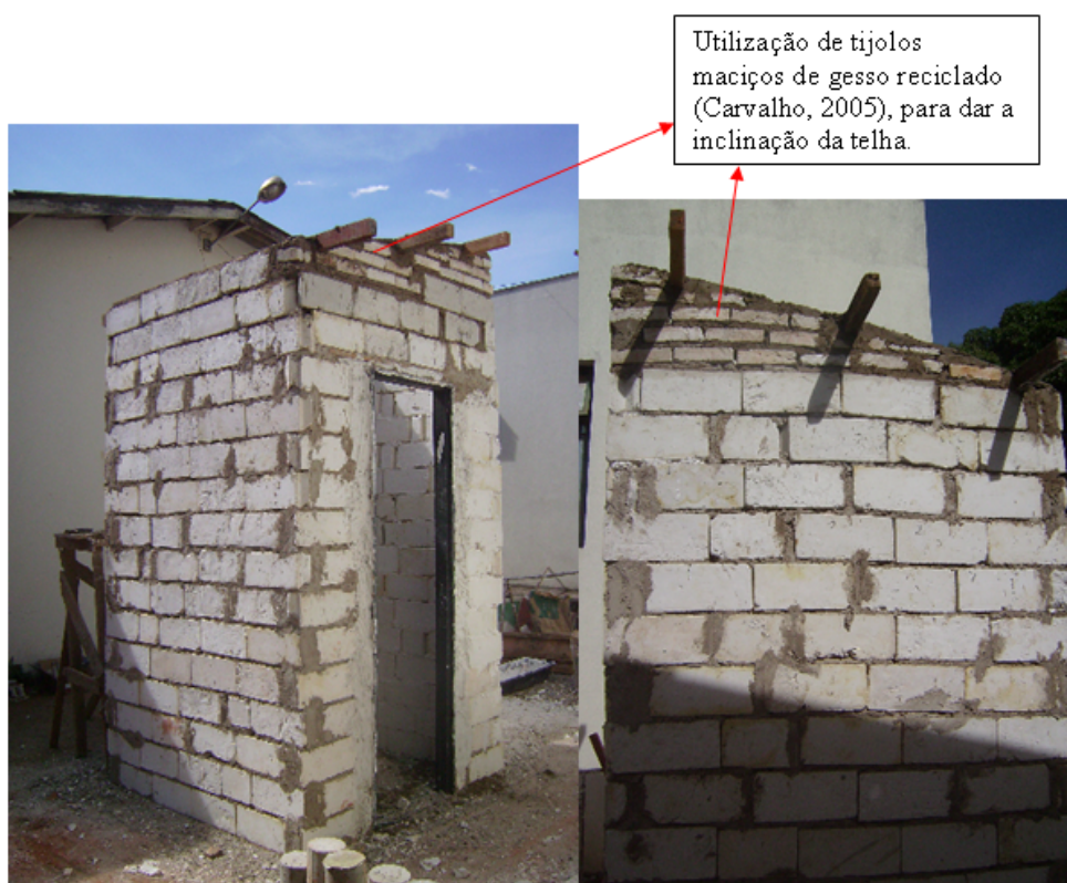
Foto 5.9 – Inclinação da alvenaria para recebimento da cobertura.
