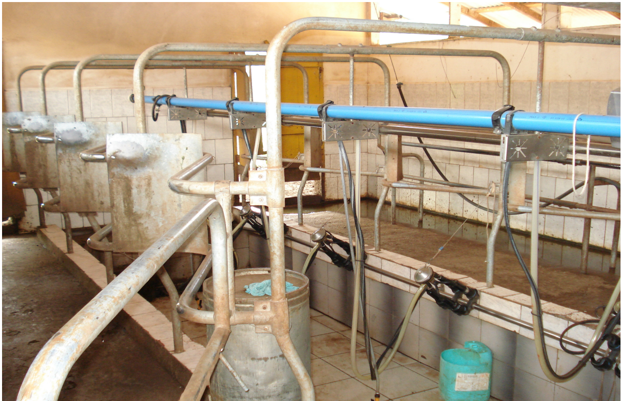
Figura 8 – Sistema de ordenha do tipo espinha de peixe.
