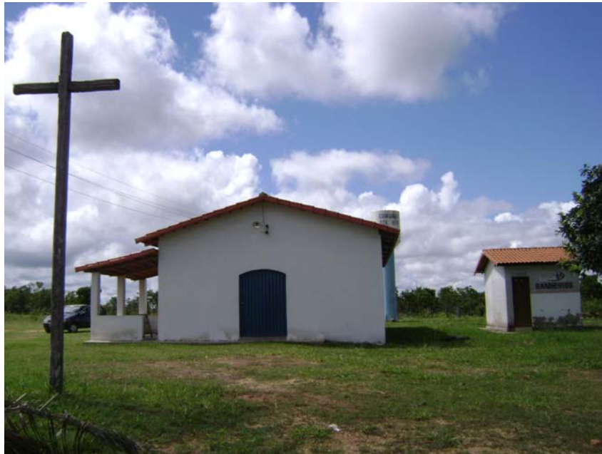
Igreja dedicada a Santa Rita ao lado do cruzeiro e ao fundo caixa d'água e instalação sanitária. Foto: Aparecida F. C. Duarte, 2008.
