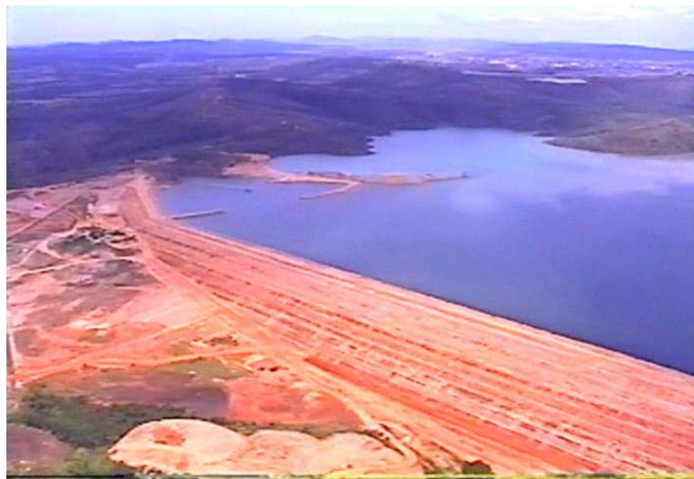
Barragem de rejeitos da RPM. Foto: CARVALHO. 16
