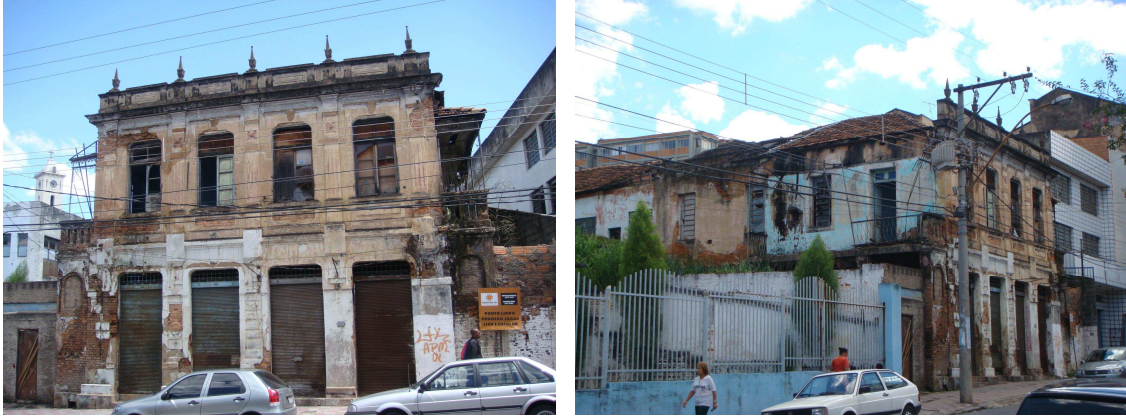
Figura 11: Edificação tombada Rua Itapecerica, 373 - vista de frente e lateral Fonte: Acervo da autora
