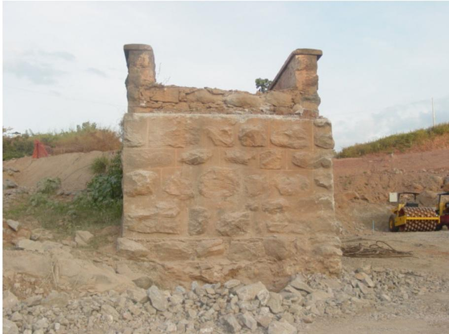
Foto 38: Cabeceira da ponte do Pau Furado na margem esquerda do rio Araguari após a retirada.
