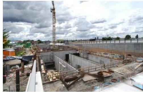
Imagens 11 e 12 – Construção de estações de tratamento de águas pluviais na A-113 em Berlim (2005) http://www.stadtentwicklung.berlin.de/bauen/strassenbau/en/bild_a113_bodenfilter.shtml
