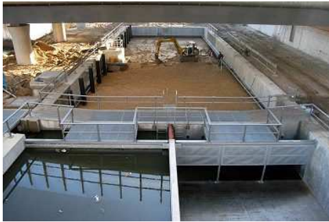
Imagens 11 e 12 – Construção de estações de tratamento de águas pluviais na A-113 em Berlim (2005) http://www.stadtentwicklung.berlin.de/bauen/strassenbau/en/bild_a113_bodenfilter.shtml
