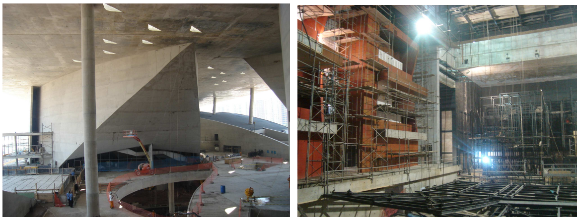
Imagens 65 e 66 – Cidade da Música em obras em 2008 (Fotos do autor)
