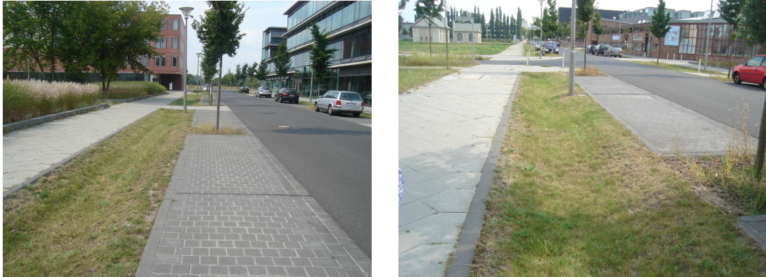
Imagens 9 e 10 - Vala para acúmulo de águas pluviais no Parque Tecnológico Adlershof em Berlim (Fotos do autor/2007)
