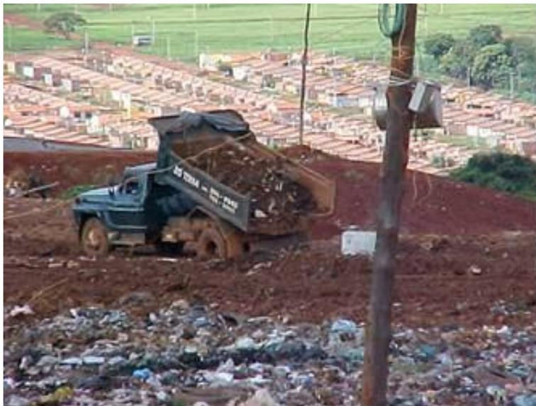
Figura 60 - Resíduo sendo disposto no aterro sanitário
