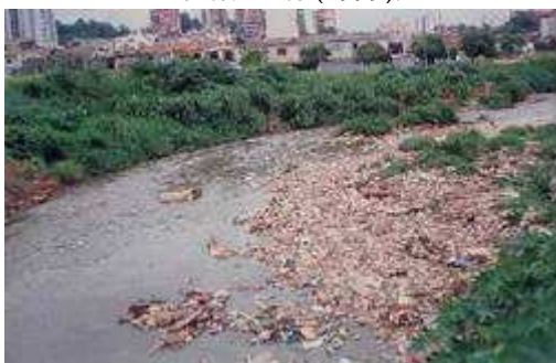
Ilustração 2.18- Obstrução do Córrego dos Meninos entre Sto. André e S. Bernardo / SP
