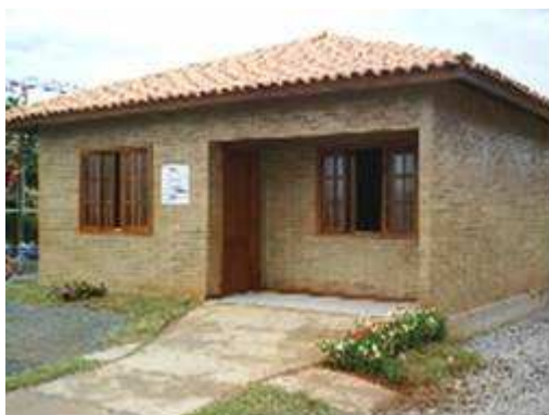
Ilustração 2.11 - Moradia construída em Macaé/RJ Fonte: Emhusa (2006)
