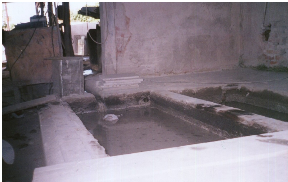
Figura 2.2 - Tanques de decantação (LOPES, 2007)
