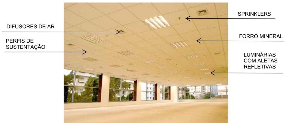
**Figura 25:** Sistemas de utilização de forros com instalação de luminárias, sprinklers e difusores de ar.
