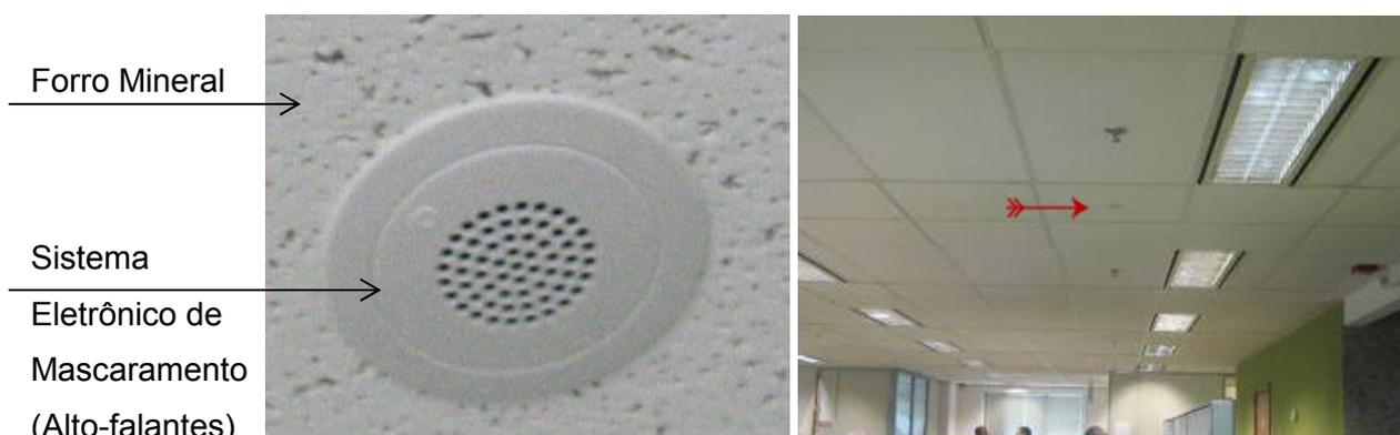
**Figura 58.** Emissores instalados sob o forro acústico detalhe e vista geral
