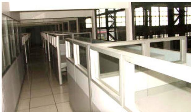
**Figura 34.** Utilização de Vidros para aumentar a altura da divisória
