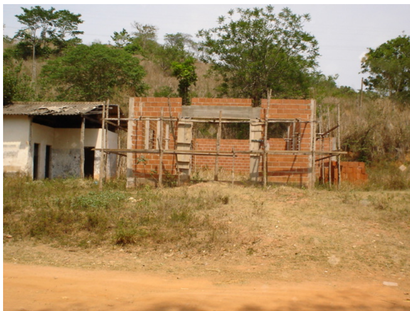
Figura 13- Construção da igreja do assentamento.
