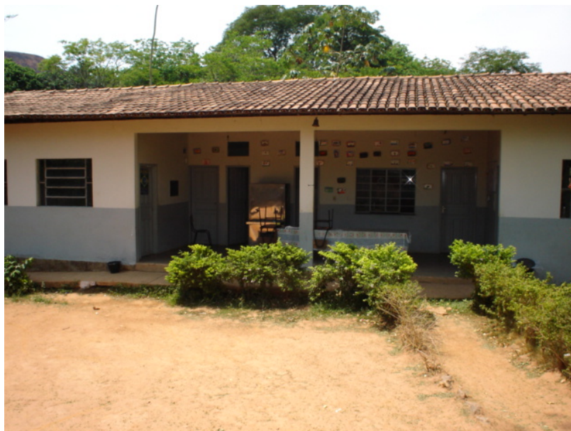
Figura 4- Vista dianteira da Escola Estadual Josimar Gomes Silva. Nos extremos estão presentes as duas salas de aula. Pode-se observar, também, a mesa utilizada para refeições e outros cômodos, a cantina, os dois banheiros e a sala da diretora.
