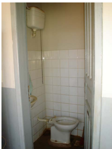
Figura 8- Banheiro da escola.
